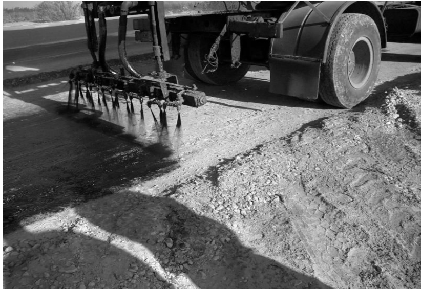
Gambar 2.1 Pelaksanaan lapis resap pengikat ( prime coat ) menggunakan Asphalt Distributor
