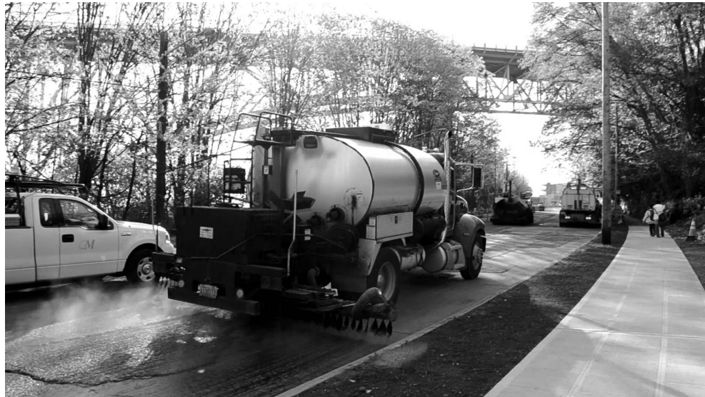
Gambar 2.2 Pelaksanaan lapis perekat ( tack coat ) menggunakan Asphalt Distributor
