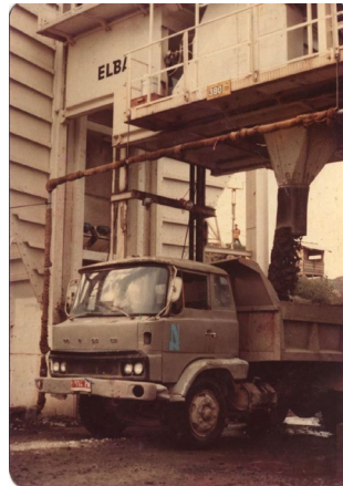
Gambar 4.9. Batcing plant dengan kapasitas \pm 70 \text{ M}^3 per jam di Proyek Dam Sampean Baru Jawa Timur. a. dilengkapi dengan dua buah silo semen. Semen dari gudang dimasukkan ke dalam silo dengan screw conveyor. Tampak sebuah dump-truck sedang diisi dengan adukan beton cair
