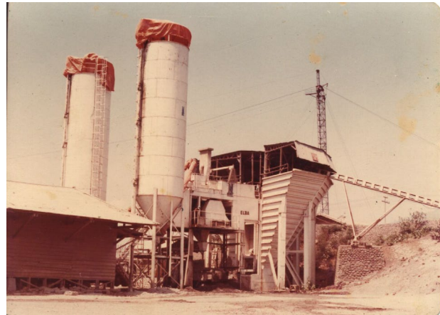
Gambar 4.9. Batcing plant dengan kapasitas \pm 70 \text{ M}^3 per jam di Proyek Dam Sampean Baru Jawa Timur. a. dilengkapi dengan dua buah silo semen. Semen dari gudang dimasukkan ke dalam silo dengan screw conveyor. Tampak sebuah dump-truck sedang diisi dengan adukan beton cair
