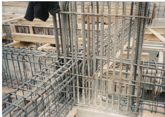
Gambar 3.20 Pemasangan besi beton pada pertemuan empat balok dan sebuah kolom, dimana ada kemungkinan terjadi jarak bersih antara besi lebih kecil dari persyaratan minimum jaraknya, sehingga agregat kasar banyak yang menyangkut, mengakibatkan keropos dibawahnya.
