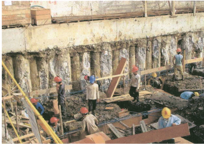
Gambar 2.4. Dinding penahan tanah proyek yang dilaksanakan oleh PT Wijaya Karya.
