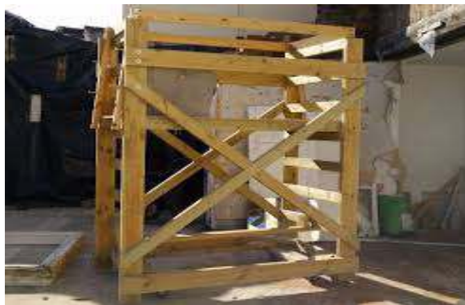
Gambar 4.14: Contoh perancah sederhana dari kayu
