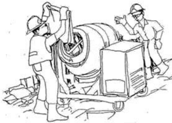
Gambar 4.7: Proses Pengadukan Dengan Alat Aduk
