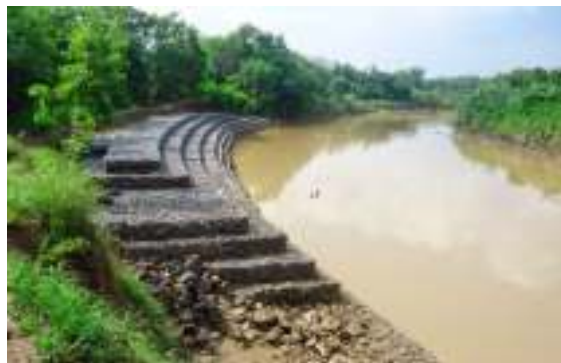
Gambar 5.1 : Penggunaan Bronjong Pada Konstruksi Tanggul
