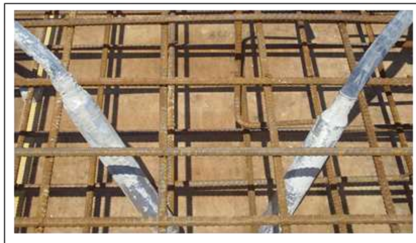
Gambar 3.6 Cara Pemasangan dengan vibrator
