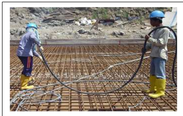
Gambar 6.1 Pembersihan dengan kompresor
