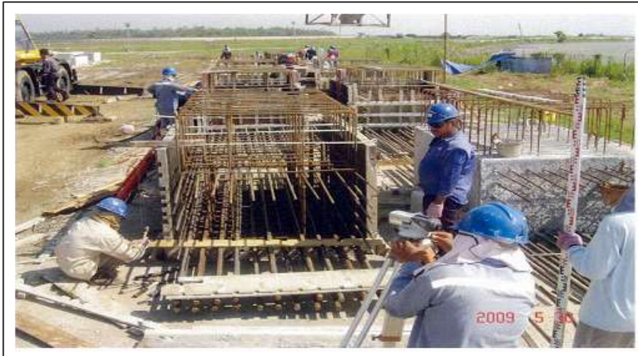
Gambar 2.25 Pengukuran lebar beton
