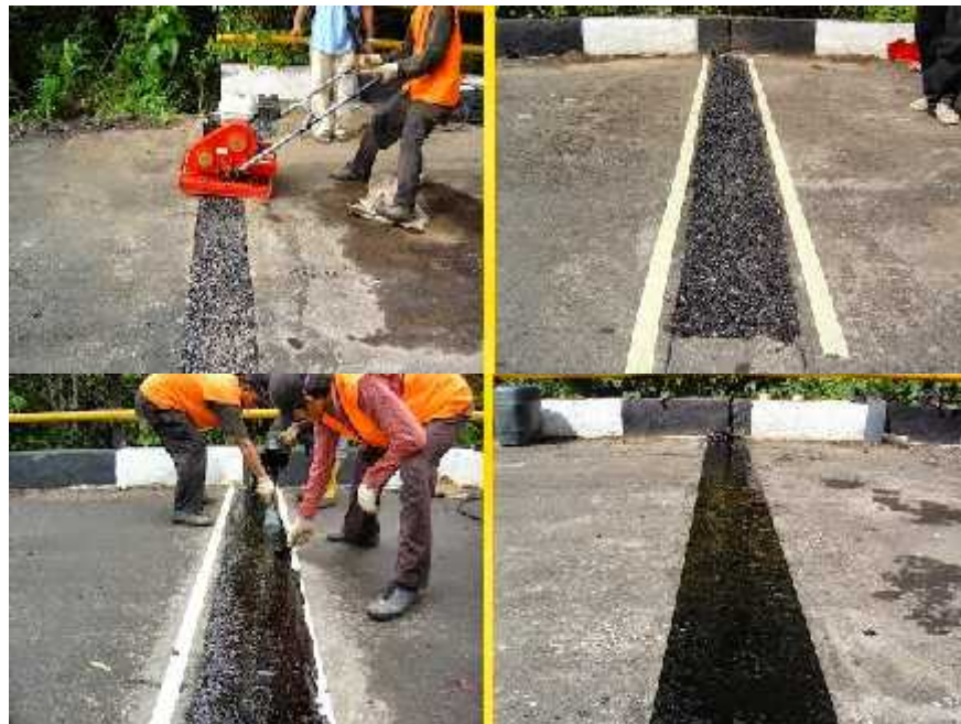
Gambar 5.4 Sambungan aspal
