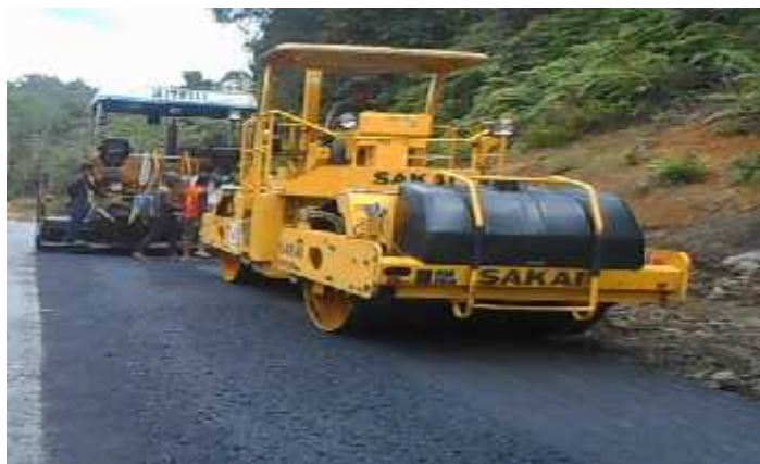
Gambar 5.3 Pemadatan aspal
