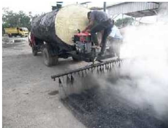
Gambar 4.1 Penyemprotan Aspal
