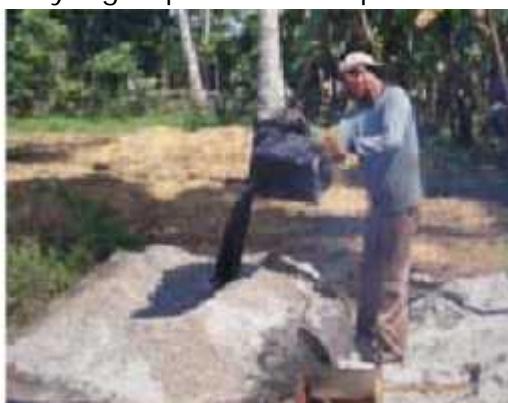
Gambar 3.2 Pencampuran Aspal
