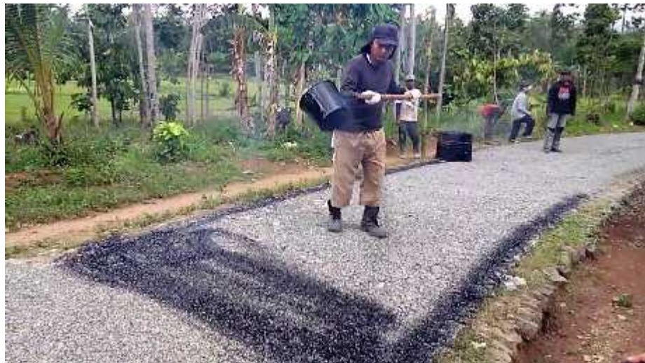
Gambar 7.3 Pekerjaan Lapis Perekat
