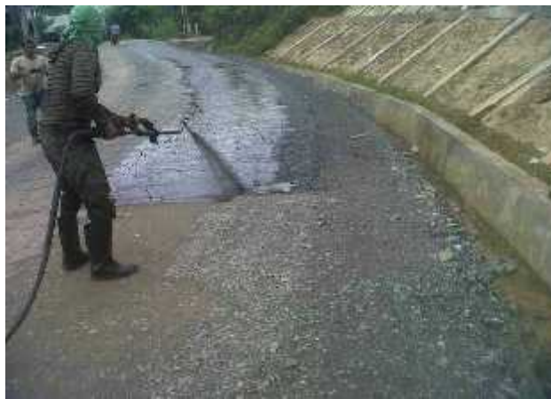
Gambar 3.4 Penyiraman/penyemprotan aspal
