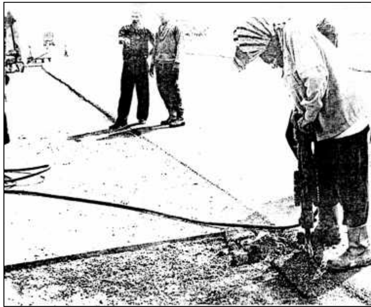
Gambar 4.9 Pelaksanaan Pemotongan lapisan lama pada sambungan dengan lapisan baru
