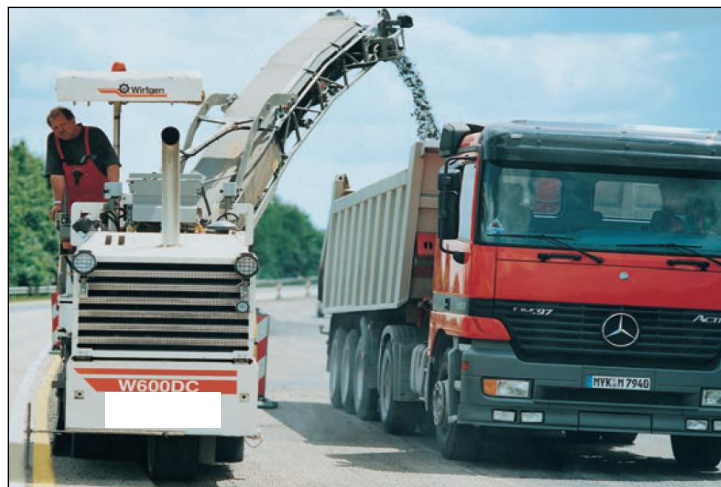
Gambar 3.12. Posisi seorang operator pada saat pengoperasian Cold Milling Machine
