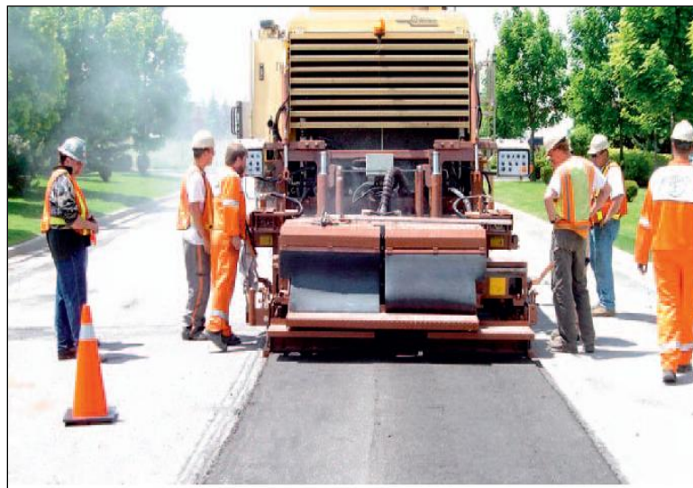
Gambar 3.14. Pemakaian Pakaian Kerja, Helmet dan Sepatu Kerja Pada Saat Bekerja Pada Pengoperasian Cold Milling Machine Sumber : Wirtgen, Amerika Serikat
