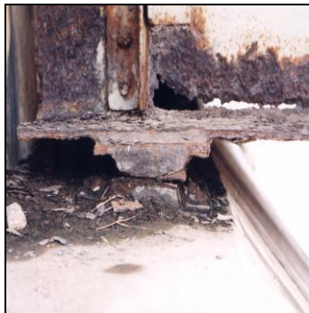
Gambar 4-7 Landasan logam berkarat
