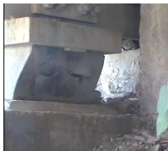
Gambar 4-8 Landasan karet deformasi dan sobek
