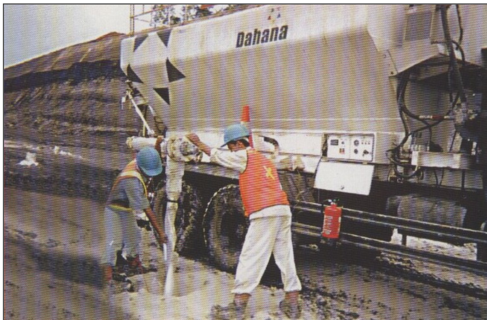
Gambar 6.4. Mengisi lubang ledak di tambang terbuka
