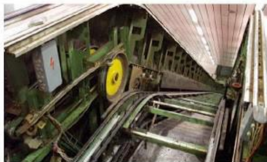
Gambar 4.41 Rangka Eskalator
