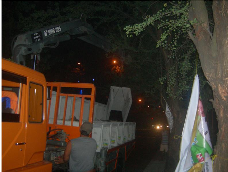
**Gambar 4.2.3 a)** Contoh pemasangan U *ditch* dengan menggunakan alat *Crane*
