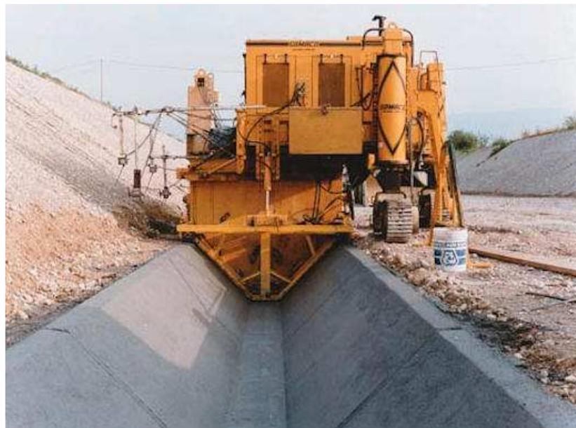
**Gambar 4.3.3 b)** Contoh peralatan pembuat lining beton untuk saluran di luar negeri dengan menggunakan alat *Canal Liner*
