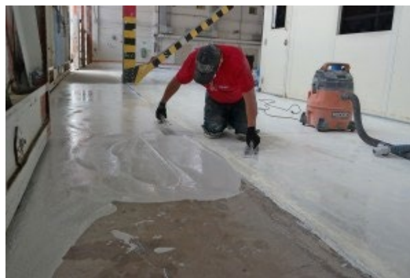
Gambar 14 : Pelapisan Kalsium Klorida
