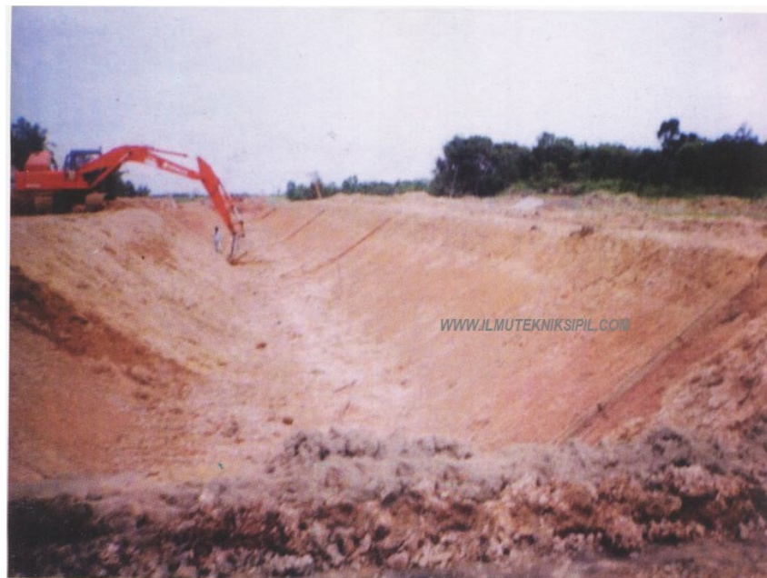
Gambar 6 : Pembentukan Saluran Irigasi
