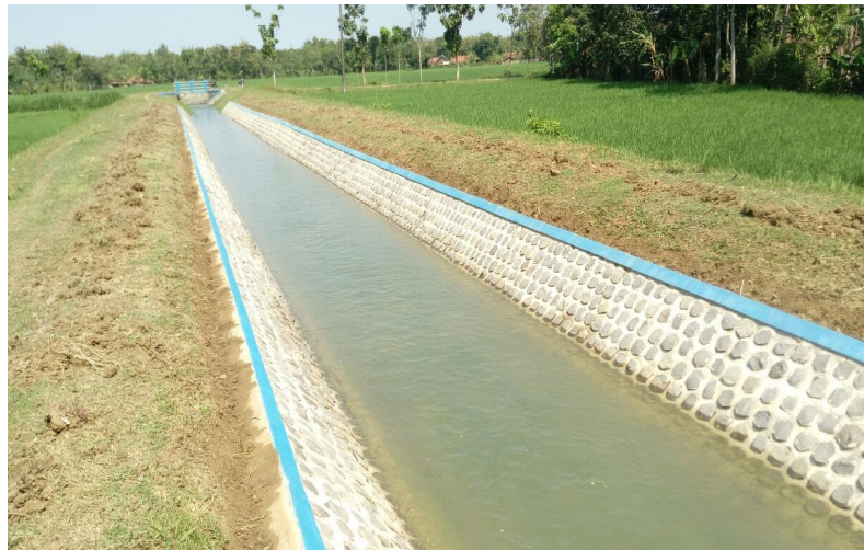
Gambar 16 : Saluran Pasangan Batu Kali
