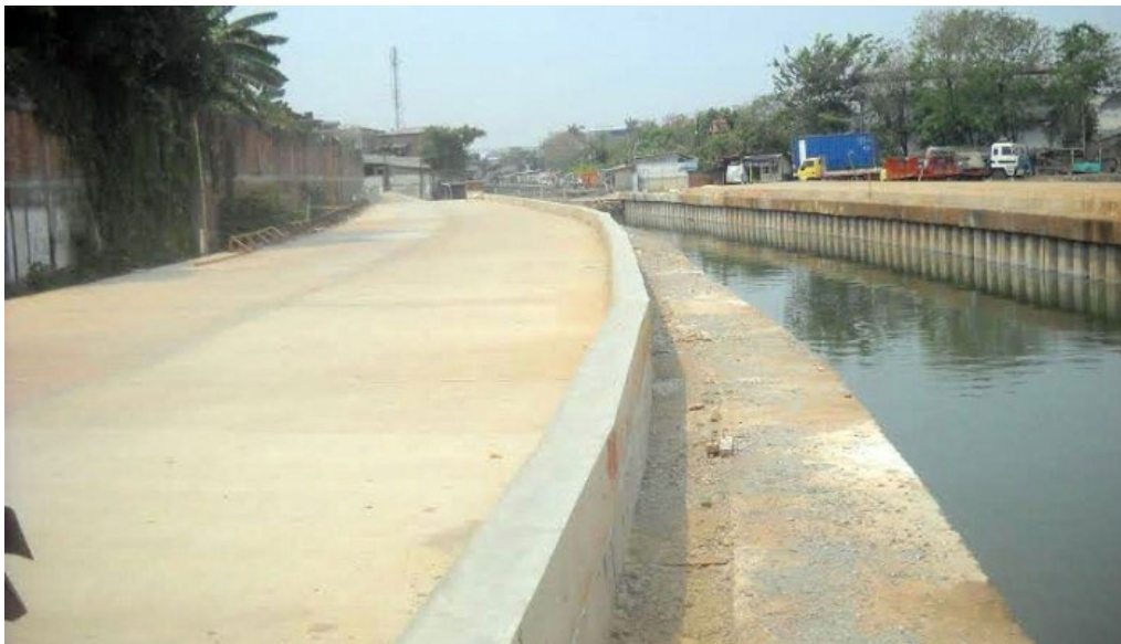
Gambar 17 : Tanggul dan Jalan Inspeksi
