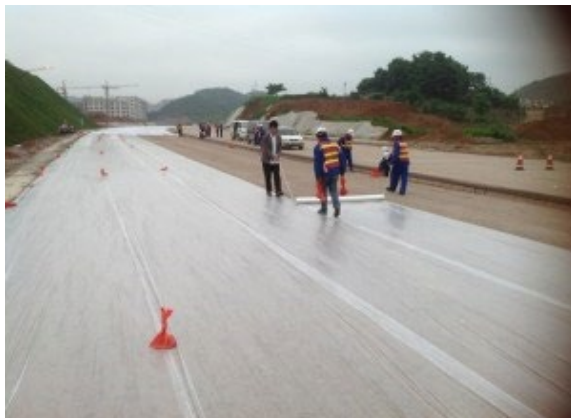
Gambar 12 : Perawatan beton cor dengan membran
