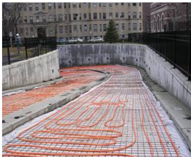
Gambar 13 : Perawatan beton dengan metode pemanasan
