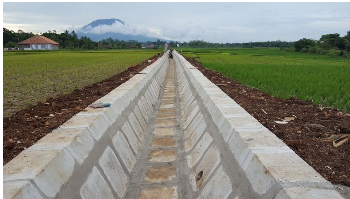
Gambar 3 : Pasangan Saluran Irigasi
