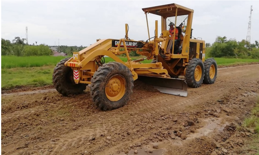
Gambar 1 : Persiapan Pekerjaan Tanah
