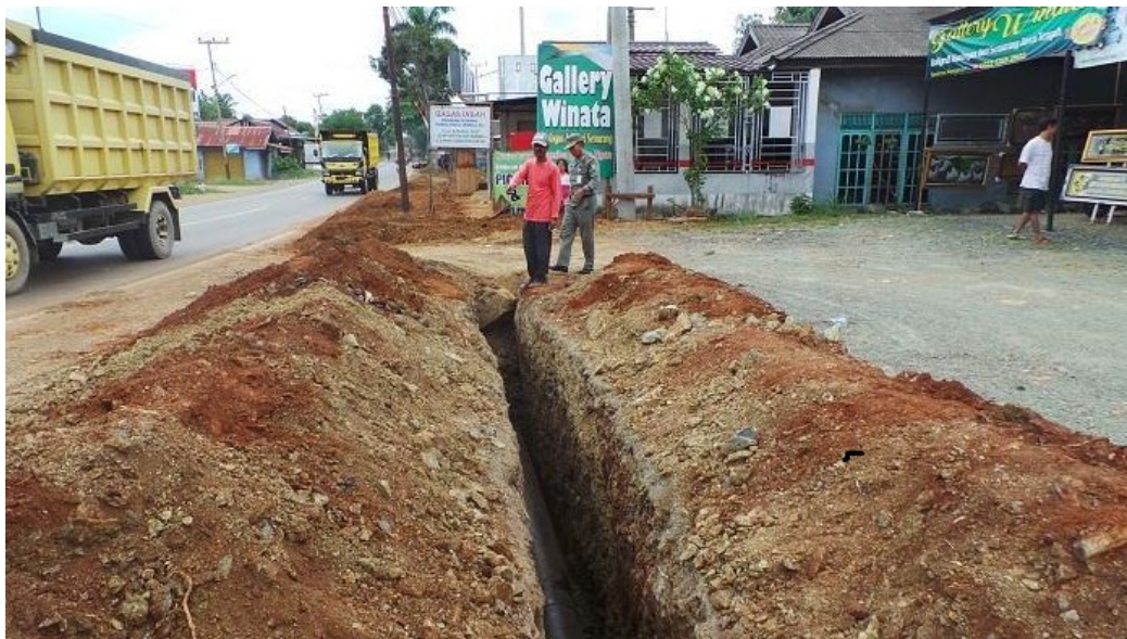
Gambar 5 : Pekerjaan Galian Saluran
