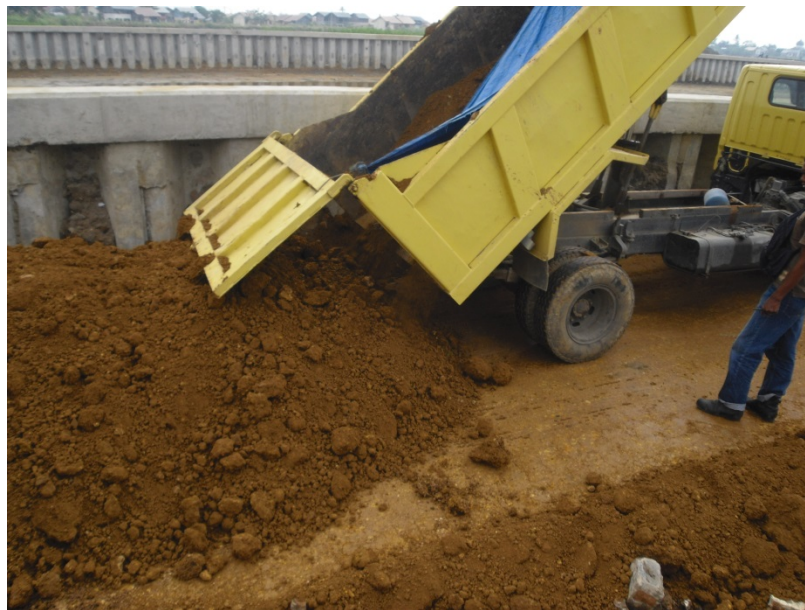
Gambar 9 : Alat Penimbun Mekanis
