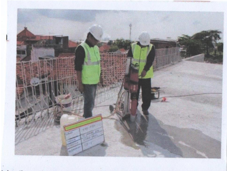
Gambar 2 : Core drill beton di lapangan
