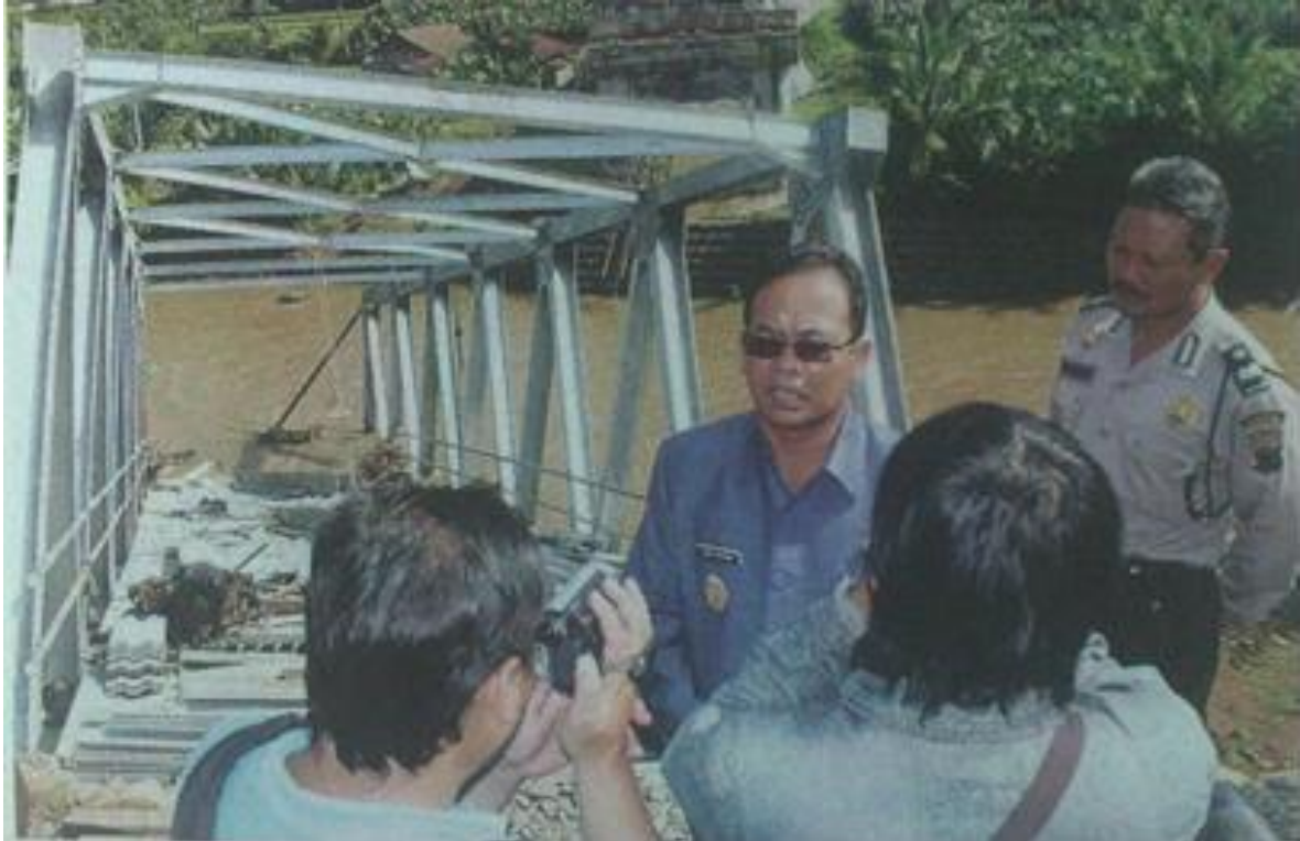
Gambar 12 : Jembatan Runtuh akibat Banjir dan Scoring
