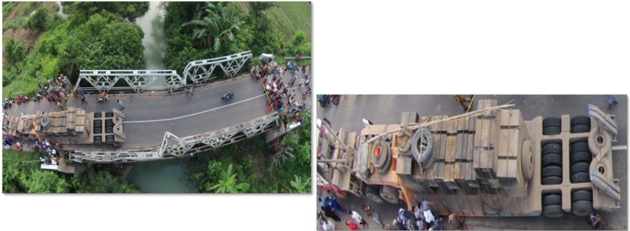
Gambar 7 : Runtuh akibat kendaraan Over Dimension dan Over Leght (ODOL)
