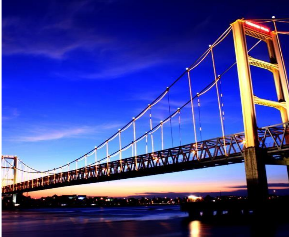
Gambar 2 : Jembatan Kutai Kertanegara sebelum runtuh
