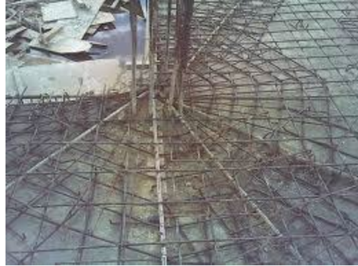
Gambar 2.4 Konstruksi Pondasi Sarang Laba-laba
