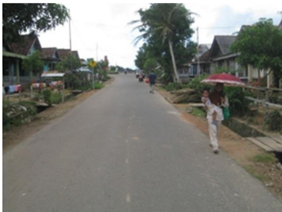
Gambar 7.22 Hazard sisi jalan.
