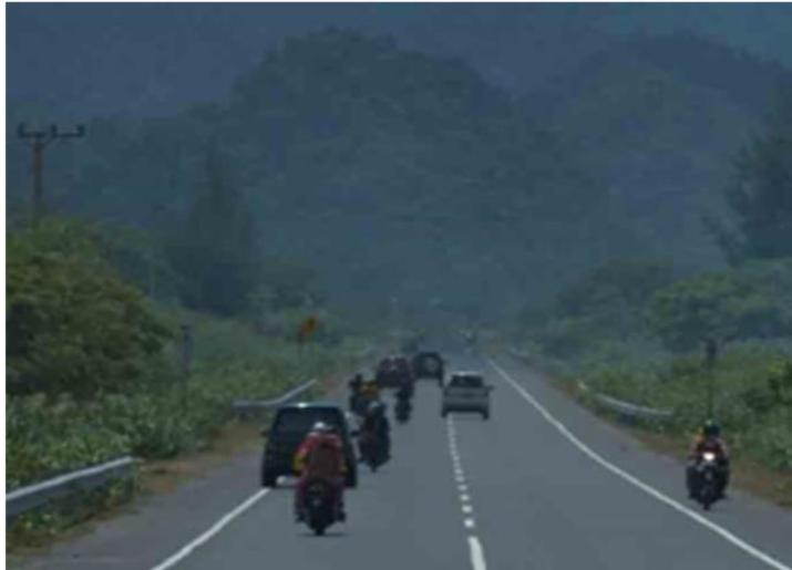
**Gambar 5.11** Sebuah contoh Jalan Nasional di daerah Rural dengan lebar 7,0 m dan bahu 2,0 m diperkeras, ditambah marka jalan yang baik dengan kemiringan melintang jalan 2% cukup untuk mengalirkan air hujan.
