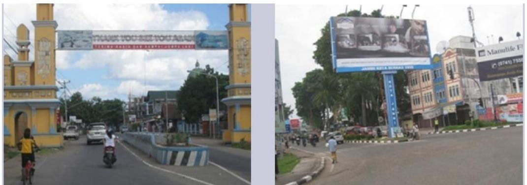
**Gambar 5.29** Kerb pada pulau jalan yang terlalu tinggi dan pilar "Billboard" di median jalan yang menjadi hazard bagi pengguna jalan.
