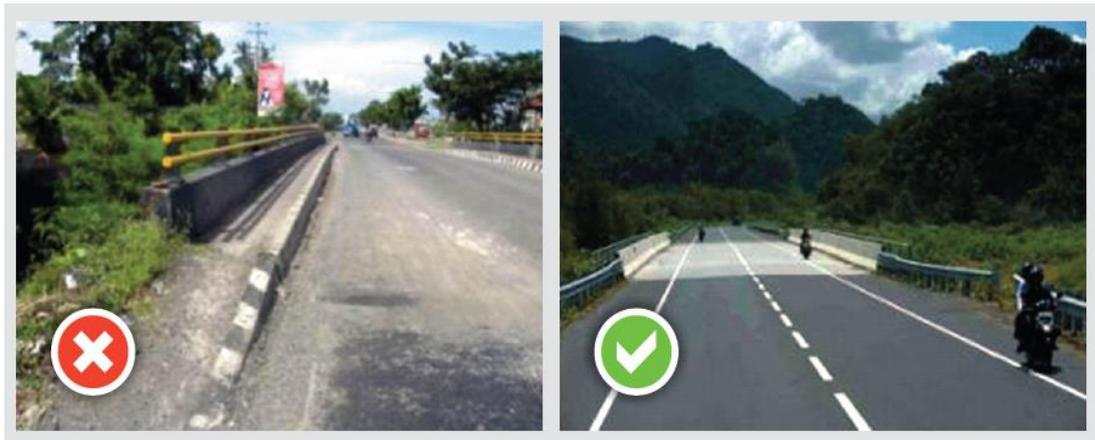
Gambar kiri : Ujung-ujung railing jembatan yang terpapar
