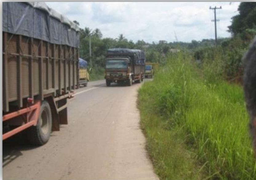
**Gambar 5.1** Jarak pandang henti yang tidak terpenuhi pada tikungan ini, karena terhalang tanaman, Ini terjadi karena tidak berjalannya pemeliharaan rutin.
