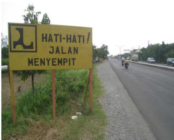
**Gambar 5.7** Rambu peringatan ini memberi tahu pengemudi/pengendara bahwa jalan menyempit. Rambu tidak mengatakan bahwa jalan yang terbagi akan habis dan empat lajur akan menjadi dua lajur. Ini harus diberi marka garis yang tegas, rambu peringatan dini serta deliniasi yang benar untuk memberi tahu dan membantu pengemudi/pengendara melebur dalam satu lajur sebelum memasuki bagian jalan
