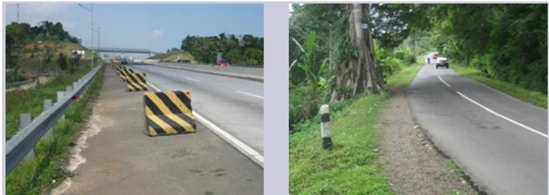
**Gambar 5.28** Penggunaan barikade beton yang tidak tepat dan ohon besar yang menjadi hazard bagi pengguna jalan.
