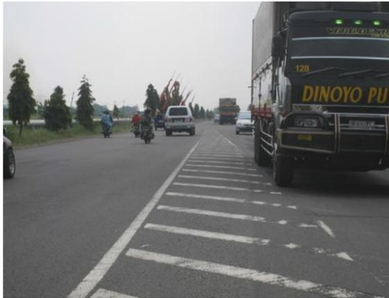
**Gambar 5.6** Pada Lokasi ini menjadi titik rawan kecelakaan. Ini terjadi karena jalan empat lajur yang terbagi menjadi jalan dua lajur dua arah yang tidak terbagi. Sudah sering terjadi tabrakan langsung di bagian dua arah jalan ini karena pengemudi/pengendara yang keluar dari bagian yang terbagi tidak menyadari bahwa potongan menyilang jalan telah berubah.
