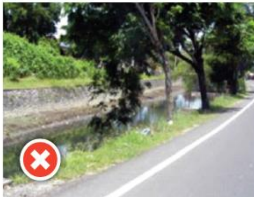
Saluran/got ini merupakan bahaya di sisi jalan Diperlukan pagar pengaman.
