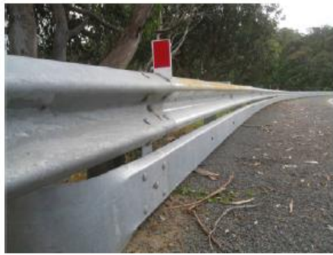
Gambar 4.5 Pelat baja pelindung sepeda motor dipasang di bawah pagar
