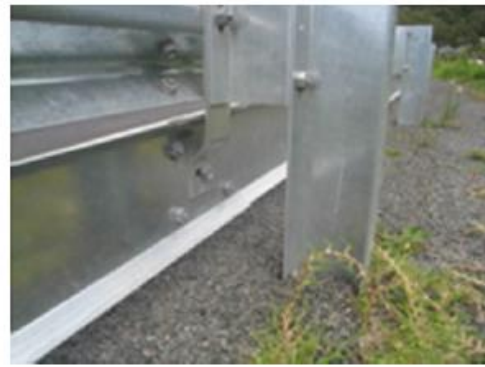
Gambar 4.5 Pelat baja pelindung sepeda motor dipasang di bawah pagar
