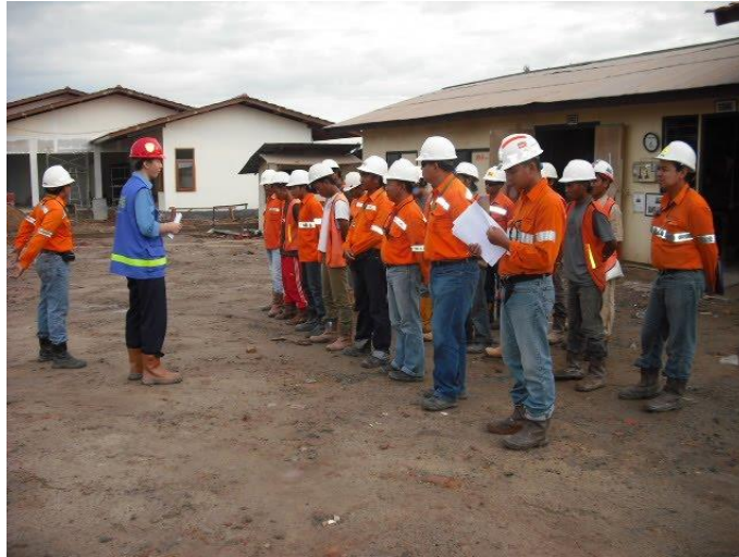
Gambar 4.2 Ahli teknik sedang berdiskusi mengenai tahap selanjutnya pada pekerjaan jalan.
