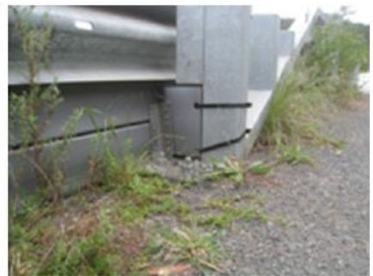
Gambar 4.6 Plastik pelindung sepeda motor dipasang di bawah pagar dan menyalut setiap tiang untuk memperlunak tumbukan.
