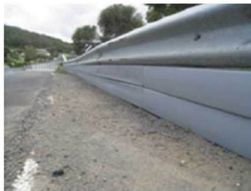
Gambar 4.6 Plastik pelindung sepeda motor dipasang di bawah pagar dan menyalut setiap tiang untuk memperlunak tumbukan.
