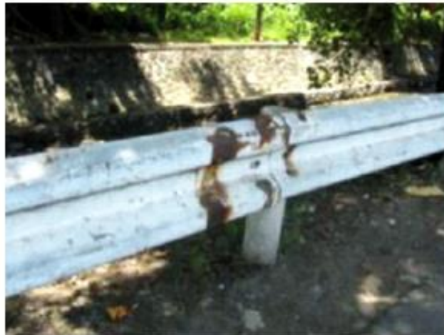
Baut yang hilang dari pagar akan mempengaruhi kinerja kecelakaan.
