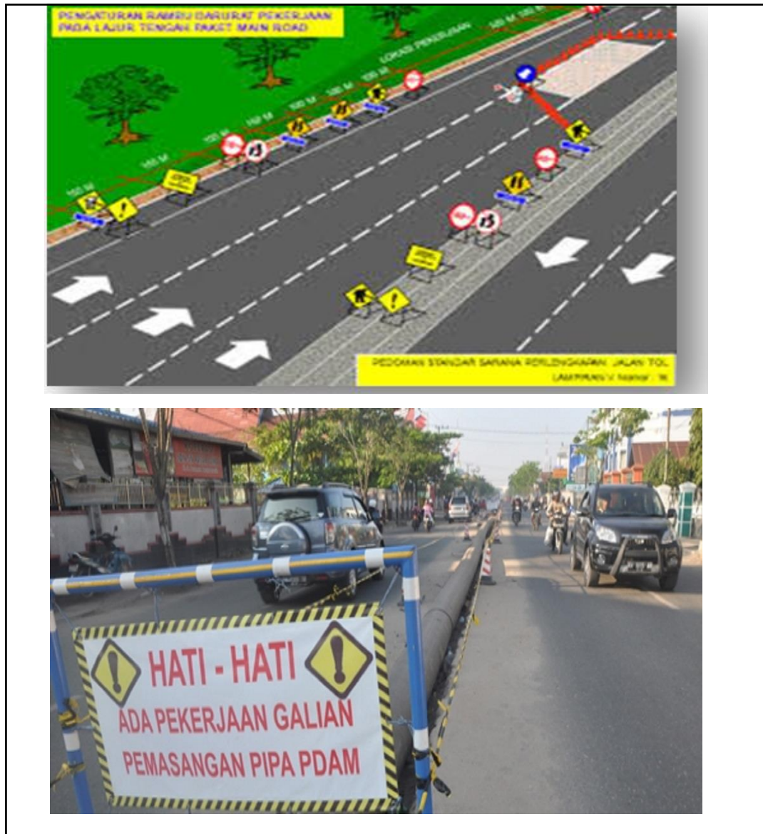
Gambar 5.1 Gambar Pemasangan Rambu Proyek
