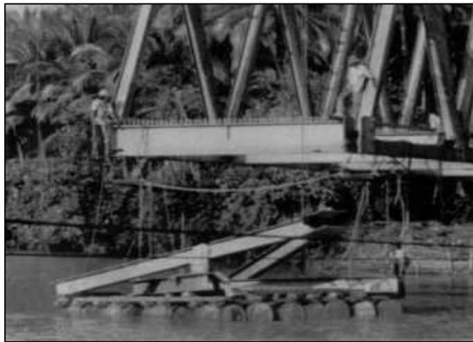
Gambar 6.6: Contoh Alat Pengangkut dengan Drum
