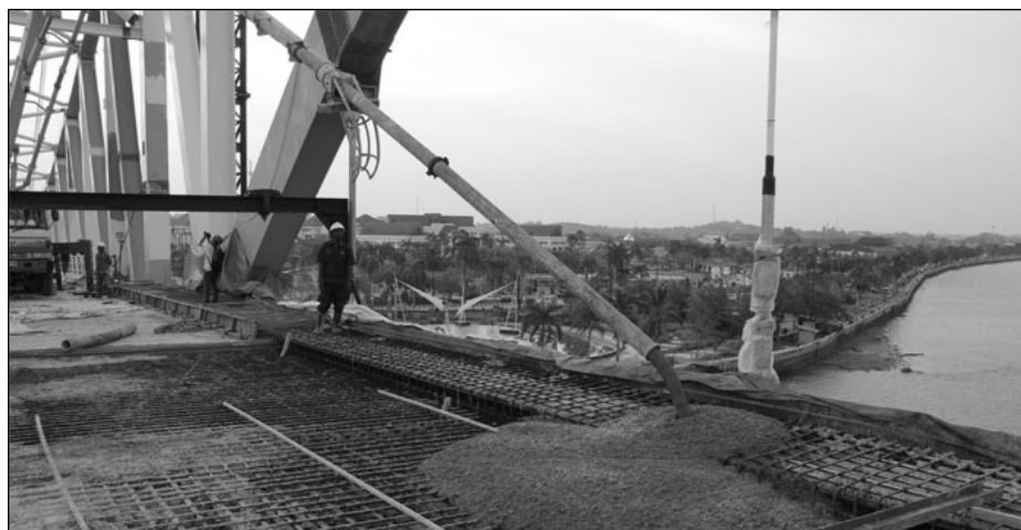
Gambar 6.11: Pengecoran Plat Lantai
