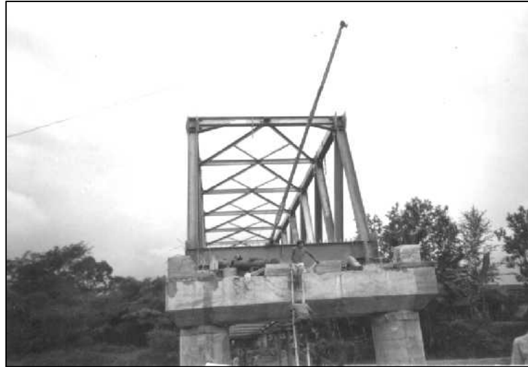
Gambar 6.7: Contoh Alat Crane Sederhana
