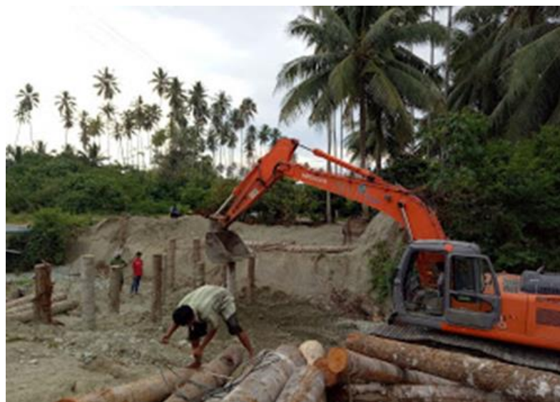
Gambar 8.2 Pembangunan Bangunan Jembatan Sementara Konstruksi Kayu
