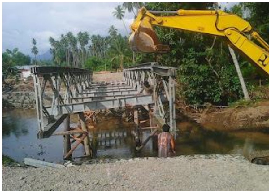
Gambar 8.4 Perakitan Jembatan Bailey
