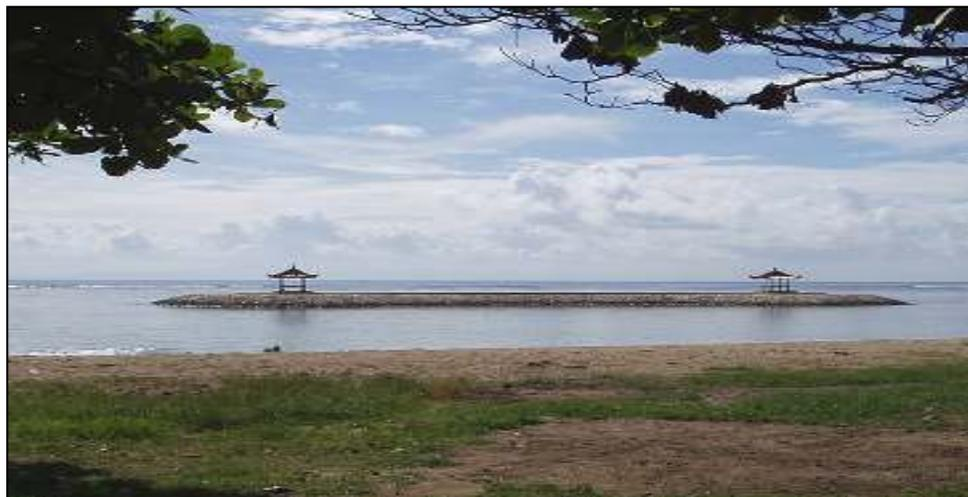
Gambar 4.34 Pengaman pantai tipe Pemecah Gelombang lepas pantai di Sanur, Bali.
