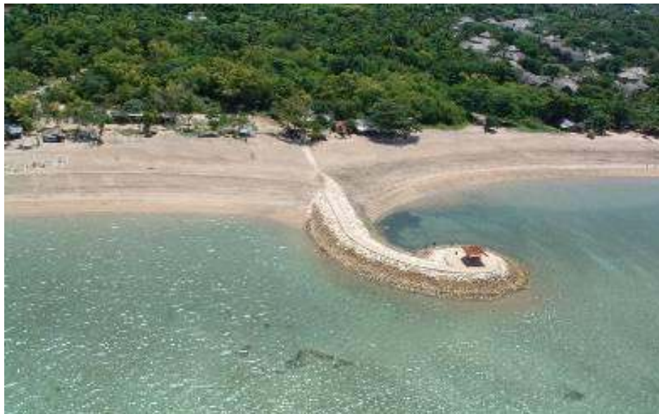
Bangunan Pengaman Pantai – krib Lengkung
