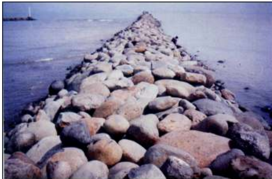
Photo 4 Konstruksi Bangunan Pengaman Pantai Jeti.
