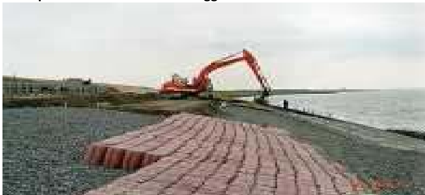
Photo 1 Tanggul laut dengan amor concrete block
