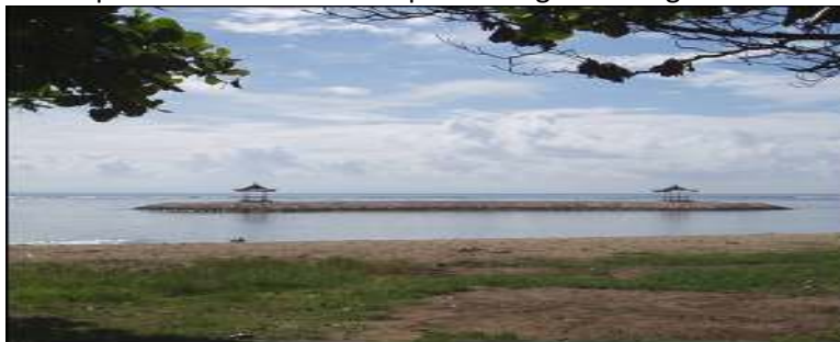
Konstruksi Bangunan Pengaman Pantai Pemecah Gelombang
