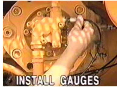
Pemasangan pressure gages
