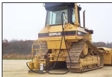
Gambar 4.11. Flushing minyak hidrolik
