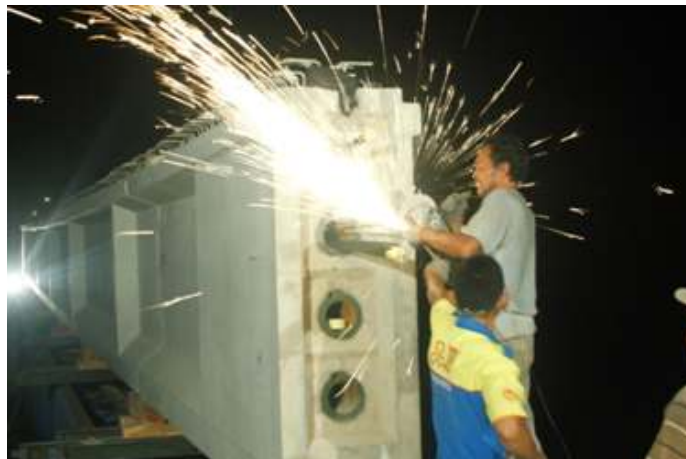
Gambar 2. 4. Pemotongan kabel strand
