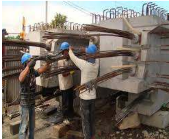
Gambar 5. 3. Proses grouting pada balok segmental
