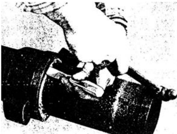
Gambar 4.7 cara memakai bagian tepi luar sambungan pipa air kotor
