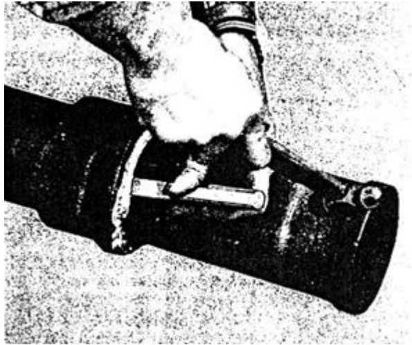
Gambar 4.6 cara memakai bagian tepi dalam sambungan pipa air kotor
