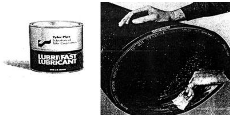
Gambar 10.4 Contoh pelumas (kiri) Cara melumasi paking karet (kanan)
