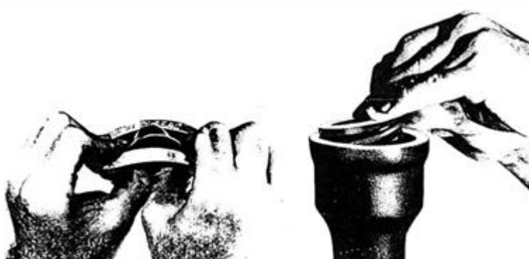
Gambar 10.2 cara melipat paking karet kompresi (kiri) dan cara memasukkan paking kompresi karet terlipat (kanan)
