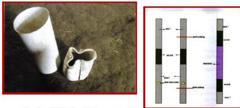
Gambar 4.4 Pipa PVC yang Rusak dan Sistem Penyambungannya
