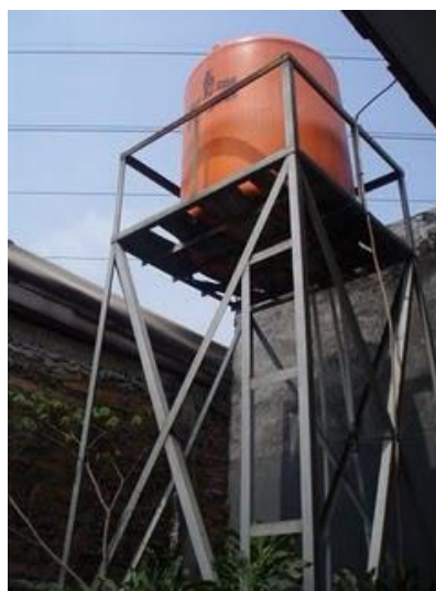
Gambar 2.3 Alas tangki yang terbuat dari kayu dan diletakkan pada menara besi Berikut adalah tatacara pemasangan dasar tangki yang harus diperhatikan
