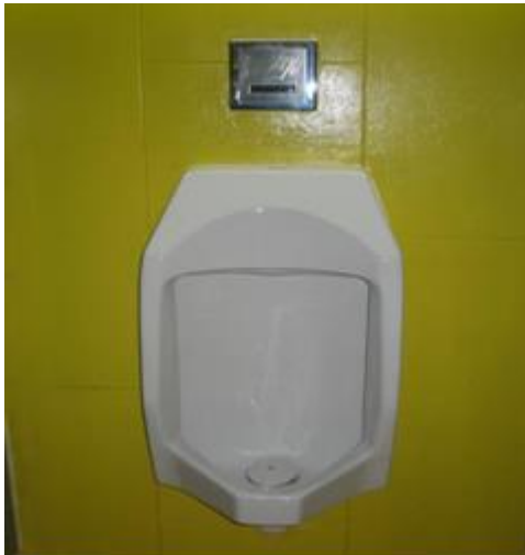
10.1 Peturasan dengan sistem sensor (kiri) dan peturasan dengan kran di atas (kanan)
