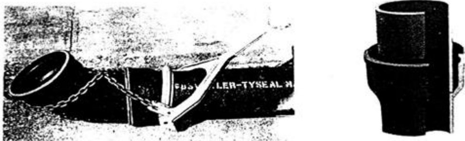
Gambar 3.24 Cara memasang fitting dengan perkakas rantai dan paking kompresi karet (kiri) Potongan memanjang sambungan paking kompresi karet yang benar, lurus pada satu garis sumbu pipa (kanan)
