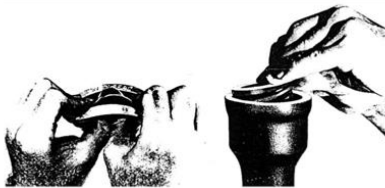
Gambar 3.21 cara melipat paking karet kompresi (kiri) dan cara memasukkan paking kompresi karet terlipat (kanan)
