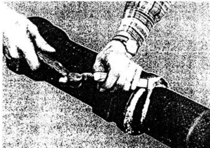
Gambar 3.6 memotong kelebihan timah hitam pada sambungan pipa datar
