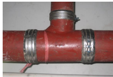
Gambar 6.7 Penyambungan dengan Menggunakan saddle Clame
