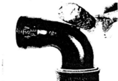
Gambar 4.7 Cara memukul fitting dengan pemukul timah hitam pada punuknya (kiri) Cara memukul fitting dengan pemukul timah hitam pada moncongnya (kanan)
