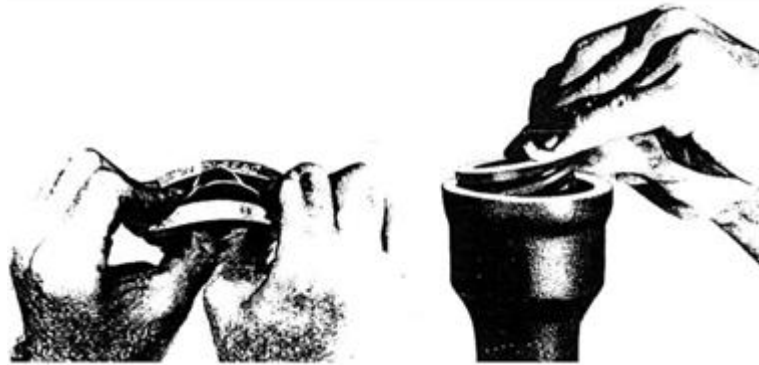
Gambar 4.3 cara melipat paking karet kompresi (kiri) dan cara memasukkan paking kompresi karet terlipat (kanan)
