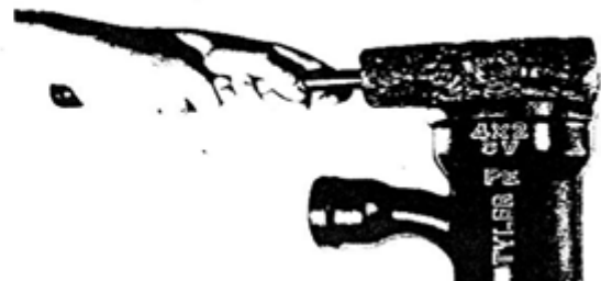
Gambar 4.7 Cara memukul fitting dengan pemukul timah hitam pada punuknya (kiri) Cara memukul fitting dengan pemukul timah hitam pada moncongnya (kanan)
