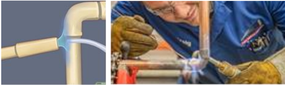
Gambar 7.18 penyolderan
