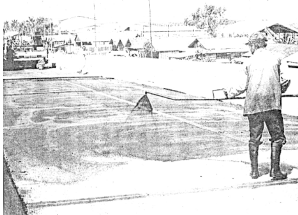
Gambar 32 : Pekerjaan Lapis Perekat
