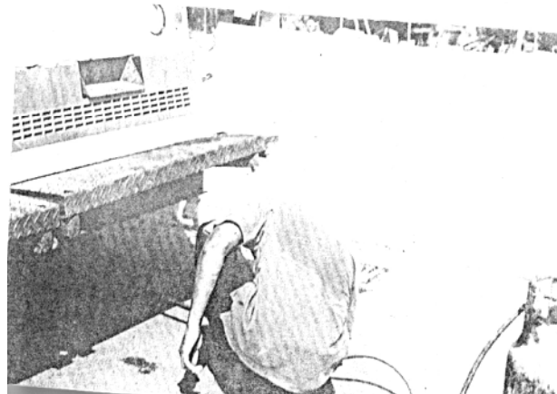
Gambar 20 : Pemanasan Sepatu (screed)
