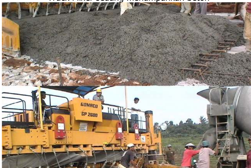
Gambar 9 : Truck Mixer sedang menumpahkan beton
