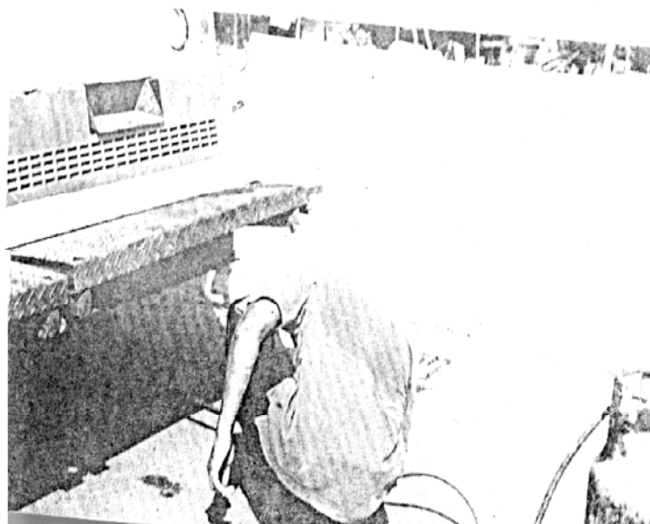
Gambar 15 : Pemanasan Sepatu (screed)
