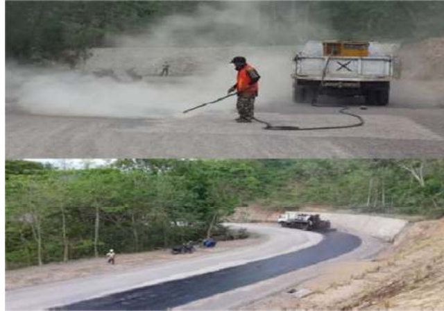
Gambar 14 : Pembersihan Debu dan Penyemprotan Tack Coat
