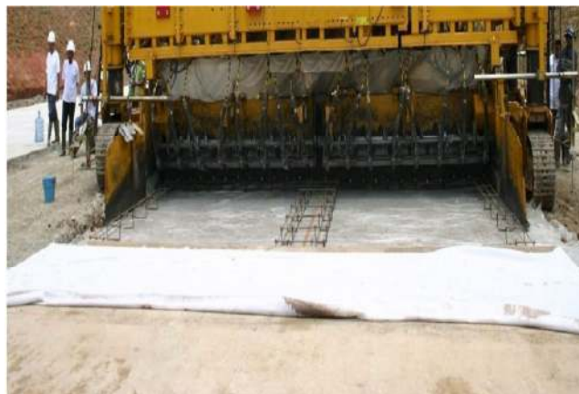
Gambar 8 : Slipform Paver
