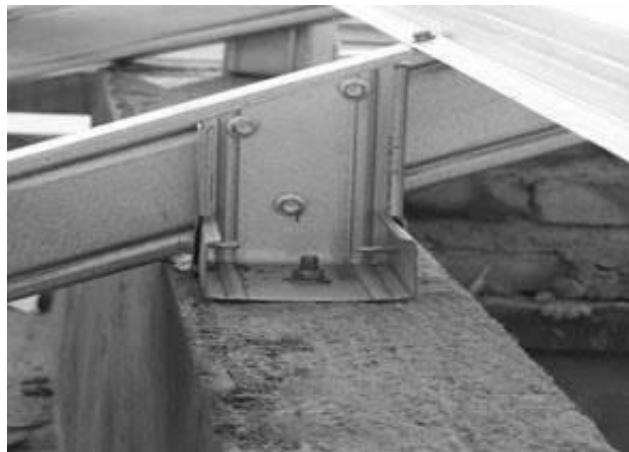
Gambar 4.5 Kuda-kuda baja ringan yang disambung ke beton dengan Dynabolt
