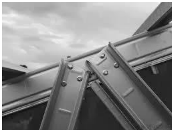
Gambar 4.3 Sambungan baja ringan dengan 3 buah screw
