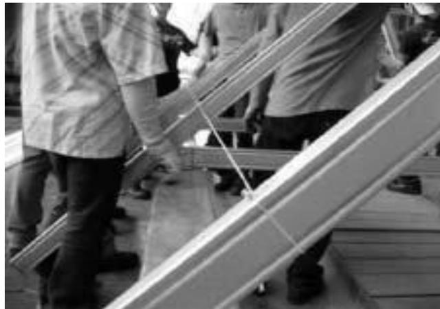
Gambar 3.5 Kontrol posisi kuda-kuda tegak lurus terhadap ring balok
