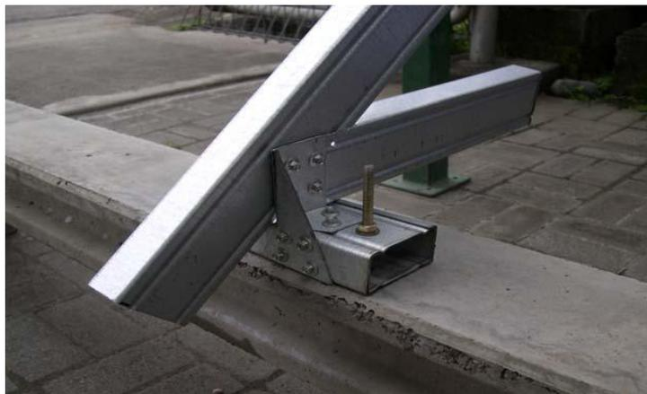
Gambar 3.1. Contoh Sistem Tumpuan Wall-plate (Kuda-kuda ditumpukan pada boxed C75.100 diikat dengan grip segitiga)
