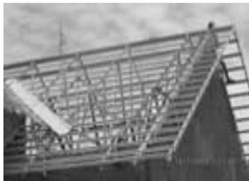
Gambar 4.5. Rangka Atap Pelana
