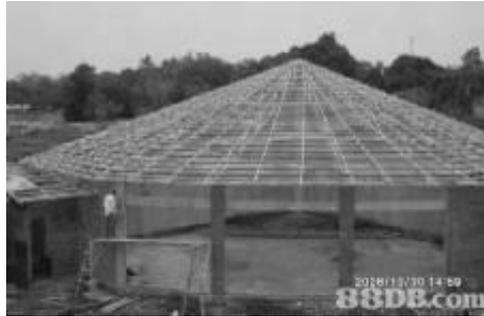
Gambar 4.7. Rangka Atap Kerucut
