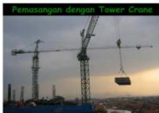
Gambar 4.11 Pemasangan Beton Precast dengan Tower Crane
