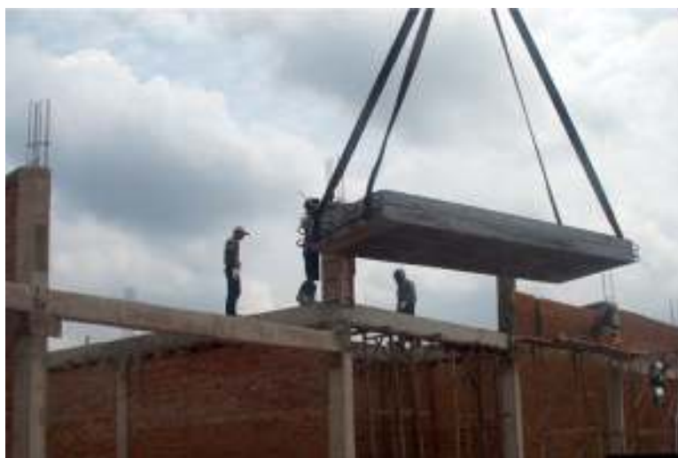
Gambar 4.1 Proses penginstalan komponen lantai beton precast
