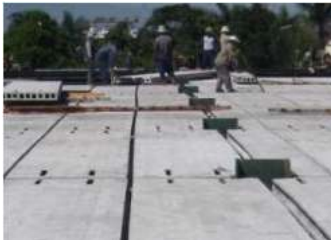
Gambar 4.15 Penyelesaian Pekerjaan Hollow Core
