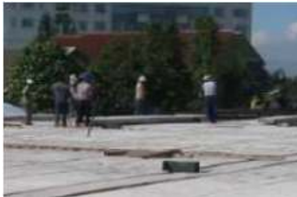
Gambar 4.14 Melakukan Pengawasan Pemasangan Precast
