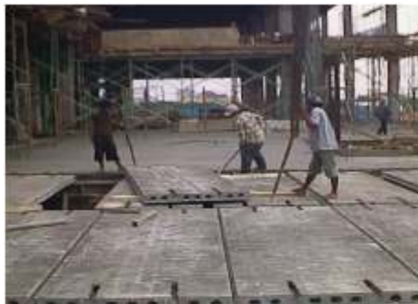
Gambar 4.13 Melaksanakan Perbaikan Pekerjaan
