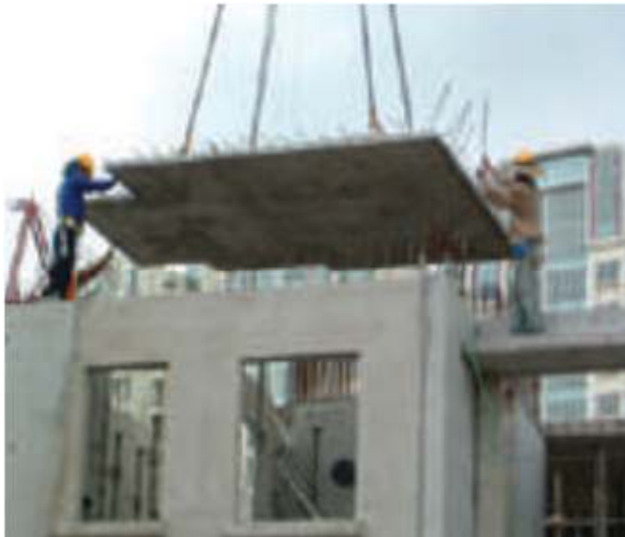
Gambar 4.35 Pengangkatan slab ke lokasi akhir
