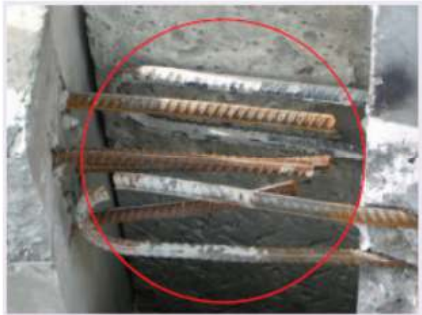
Gambar 4.32 Panjang tulangan baja yang menonjol sesuai spesifikasi
