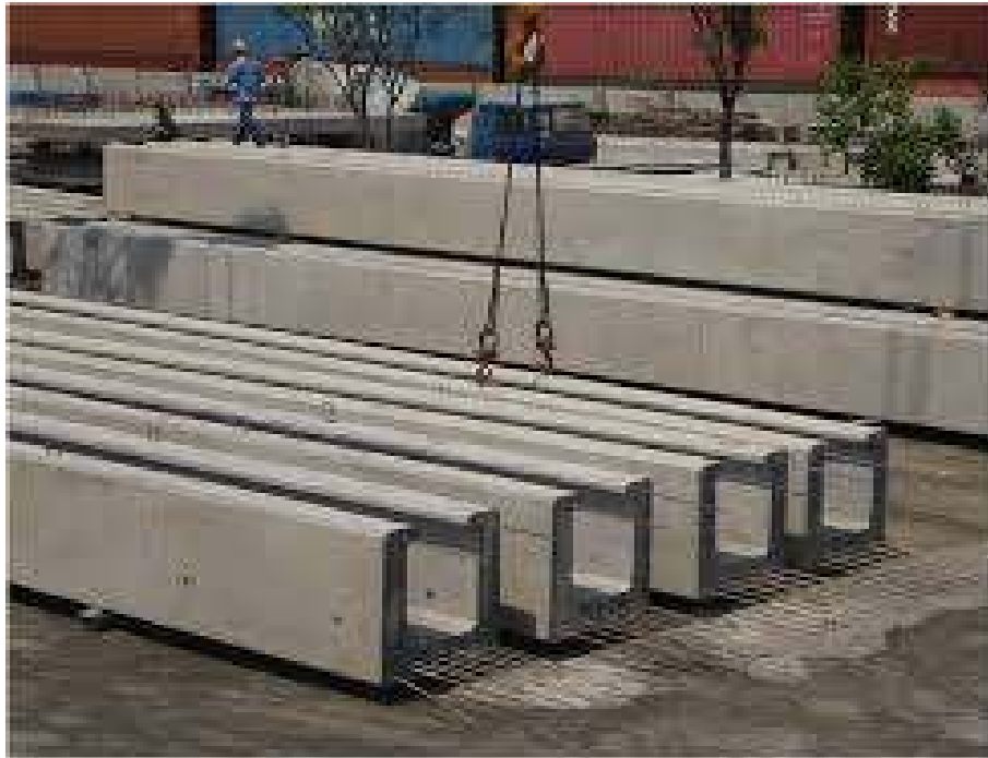
Gambar 4.54 Titik angkat pada balok U precast
