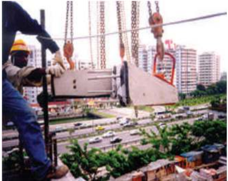
Gambar 4.36 Pengangkatan slab balkon
