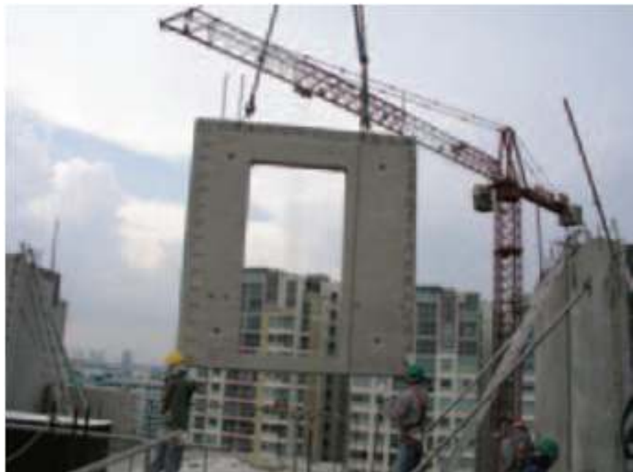
Gambar 4.17 Mengangkat panel beton precast ke titik lokasi
