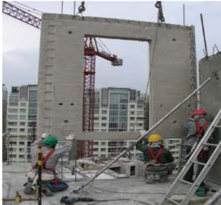
Gambar 4.18 Periksa kondisi pengangkatan elemen precast –
