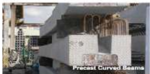
Gambar 4.9 Tempat penyimpanan komponen beton precast di lokasi proyek
