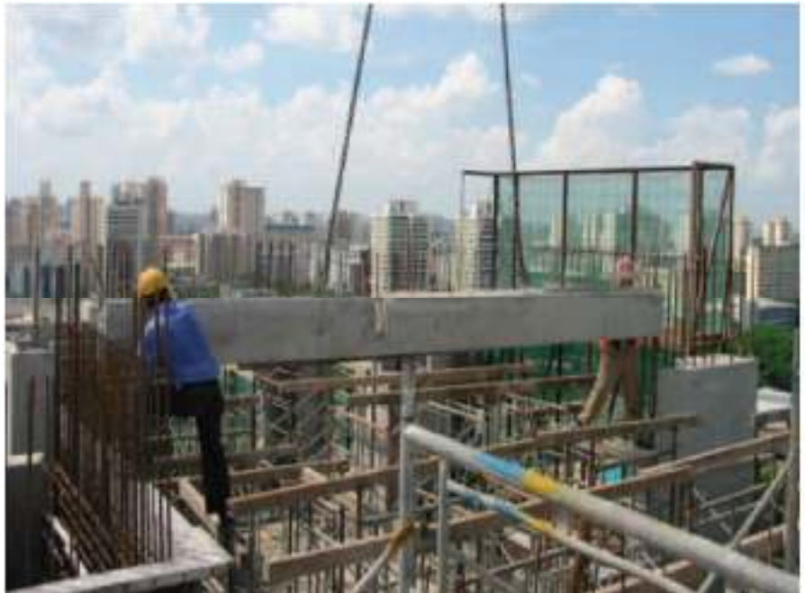
Gambar 4.34 pengangkatan balok precast
