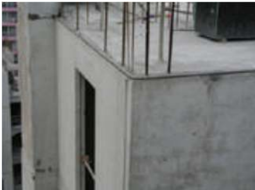
Gambar 4.15 Dinding dan kolom precast eksternal
