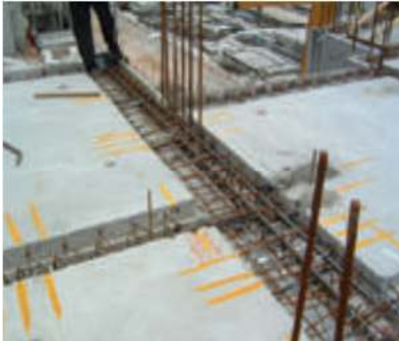
Gambar 4.40 Baja tulangan untuk sambungan harus tepat ditempatkan sesuai dengan spesifikasi teknis
