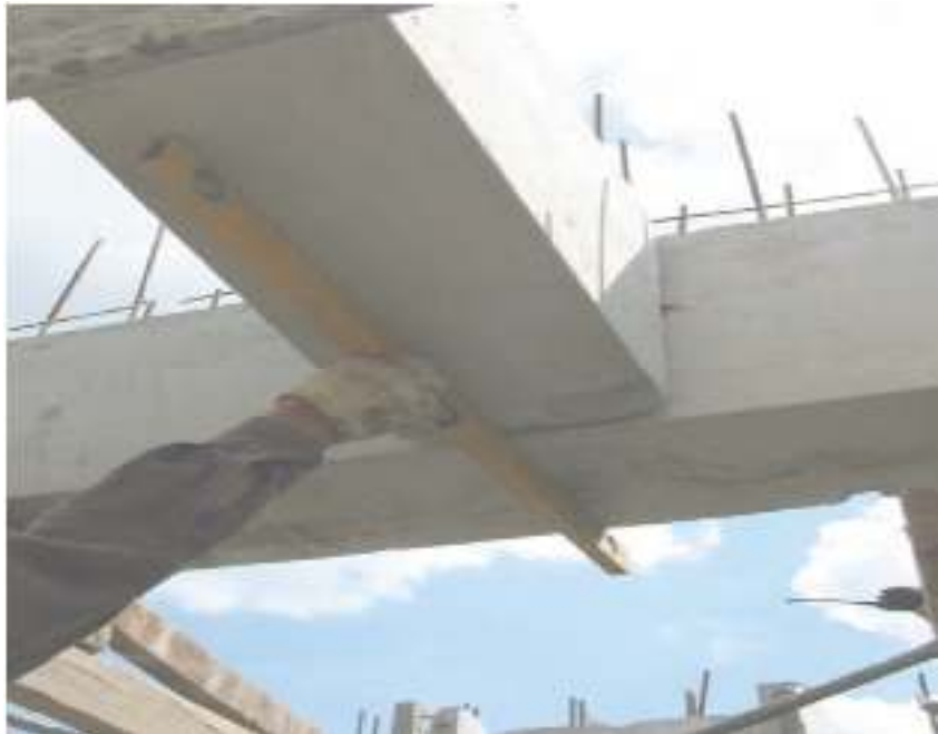
Gambar 4.38 Pengukuran kedataran beton precast setelah dipasang
