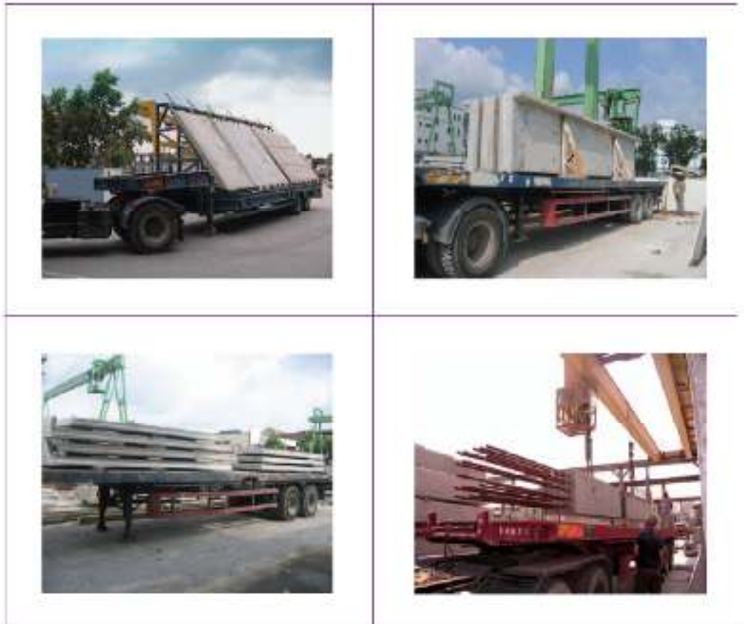
Gambar 4.8 Berbagai alat angkut beton precast
