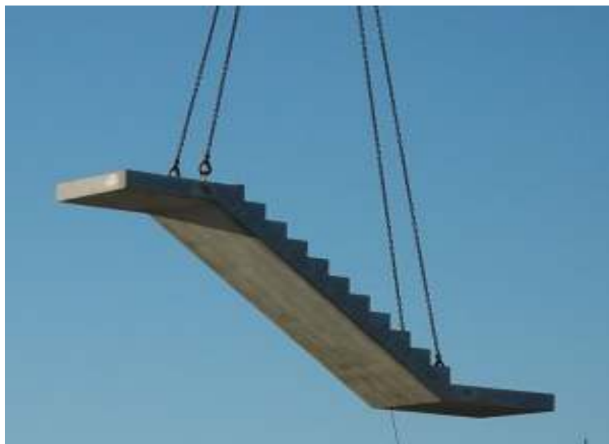
Gambar 4.53 Letak titik angkat pada tangga precast
