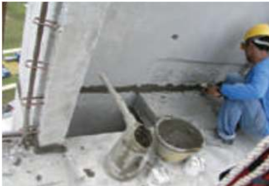
Gambar 4.23 Memasang aduk tanpa susut pada bagian bawah dinding
