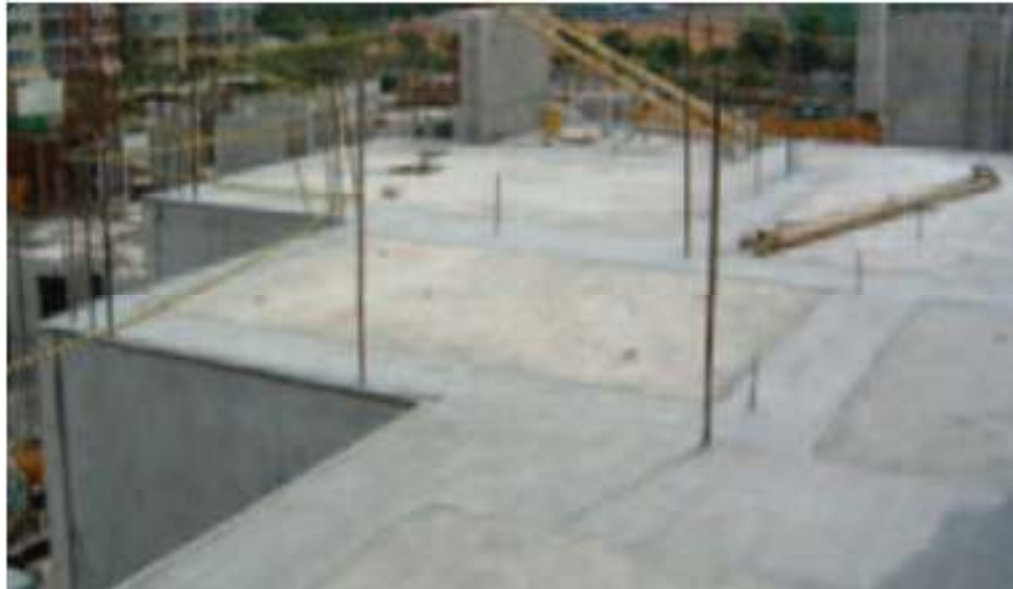
Gambar 4.43 Topping beton yang telah dicor
