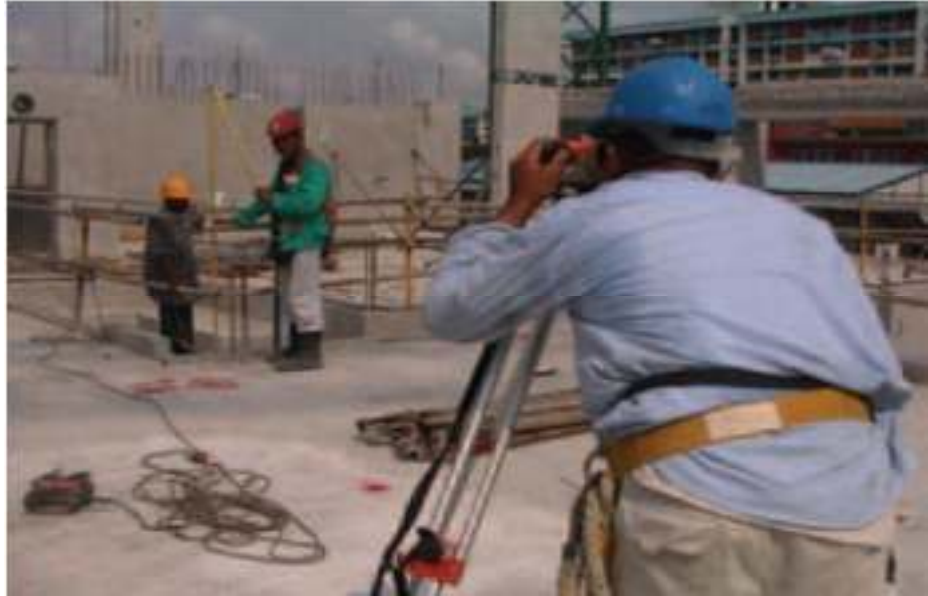
Gambar 4.12 melakukan pengukuran untuk menentukan titik lokasi penempatan komponen beton precast
