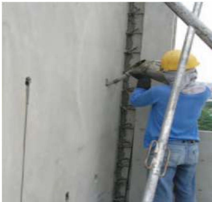
Gambar 4.25 Menuangkan adukan kedalam pipa inlet yang tersedia
