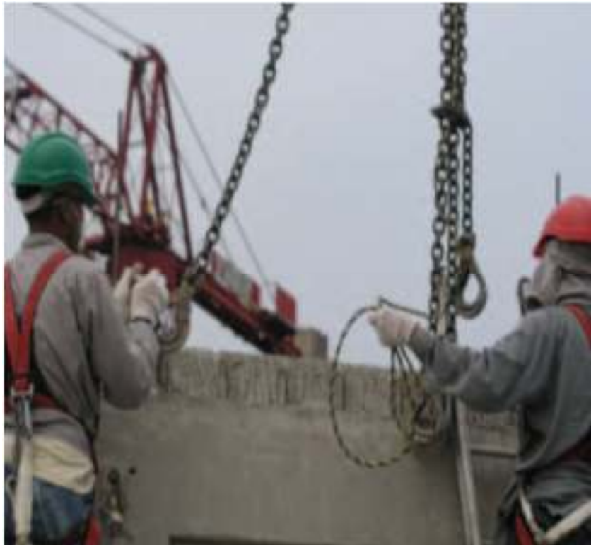
Gambar 4.21 Periksa stabilitas alat penyangga ereksi sebelum melepaskan kabel kerekan
