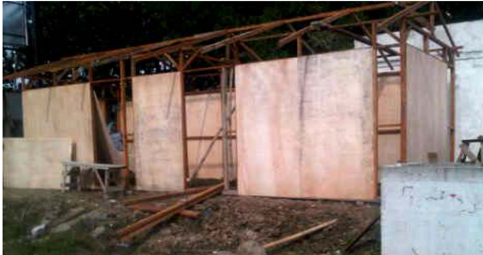
Gambar 4.1 Konstruksi Bedeng pekerja
