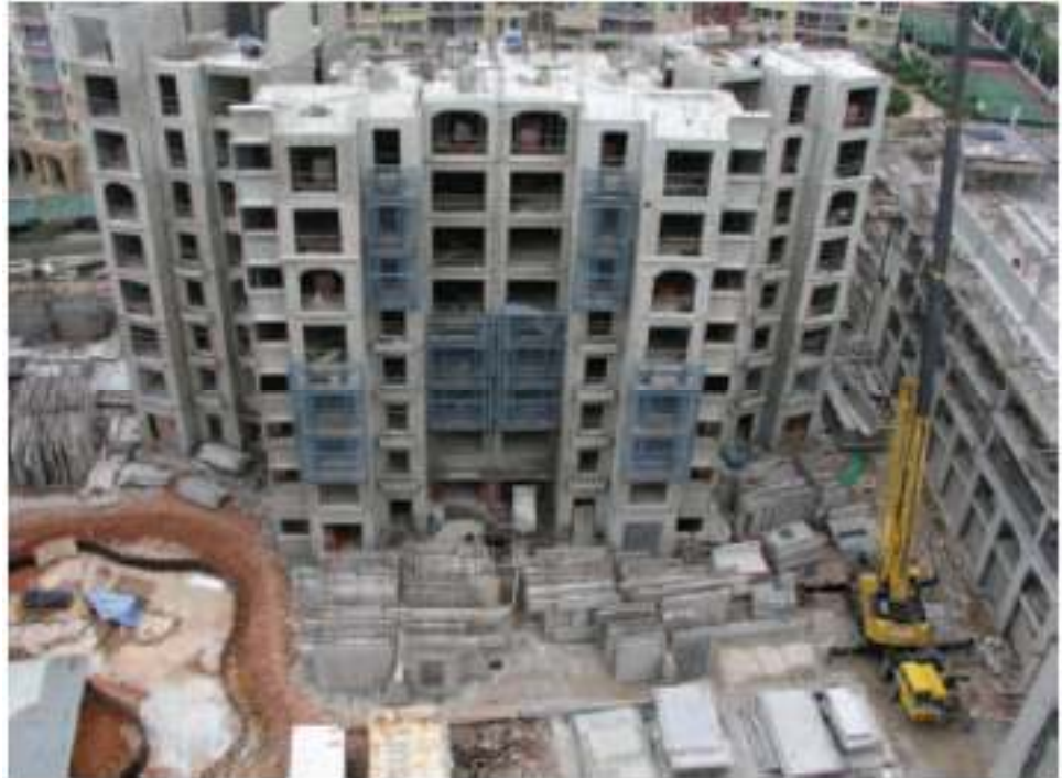
Gambar 4. 7 Penempatan bahan harus dalam jangkauan tower crane supaya mudah diangkat
