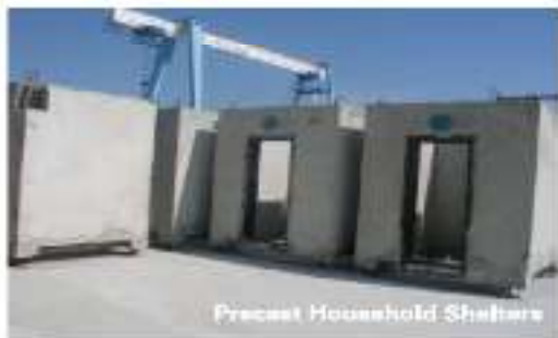
Gambar 4.9 Tempat penyimpanan komponen beton precast di lokasi proyek
