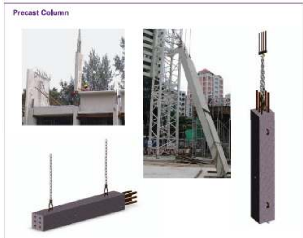
Gambar 4.52 Letak titik angkat pada kolom precast
