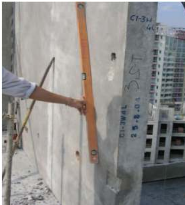
Gambar 4.19 Periksa kesejajaran dan vertikalitas panel. Jika diperlukan, atur ganjal sementara untuk mencapai tingkat dan posisi dari elemen precast
