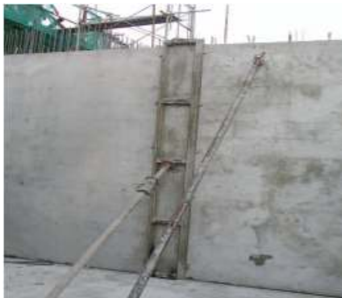
Gambar 4.28 Bekisting harus diamankan selama operasi pengecoran sambungan
