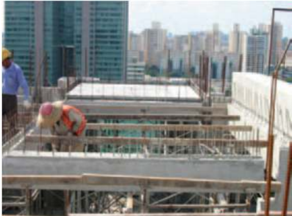
Gambar 4.33 Pemasangan alat penyangga balok
