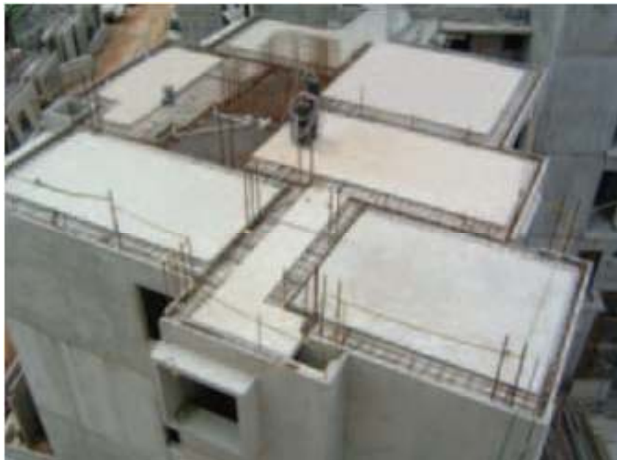
Gambar 4.41 Bekisting harus aman selama pengecoran sambungan
