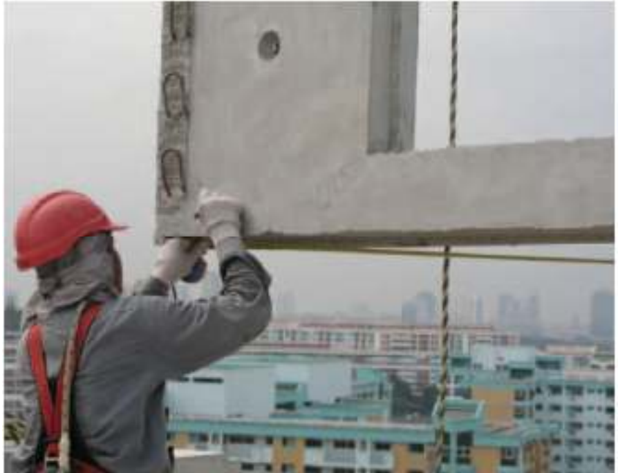
Gambar 4.16 Periksa bahwa bentuk kompresibel atau batang pendukung dijamin aman
