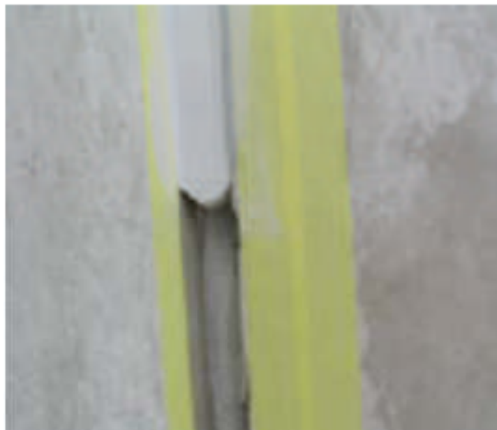
Gambar 4.30 Pengisian sealant atau nat pada celah antar sambungan
