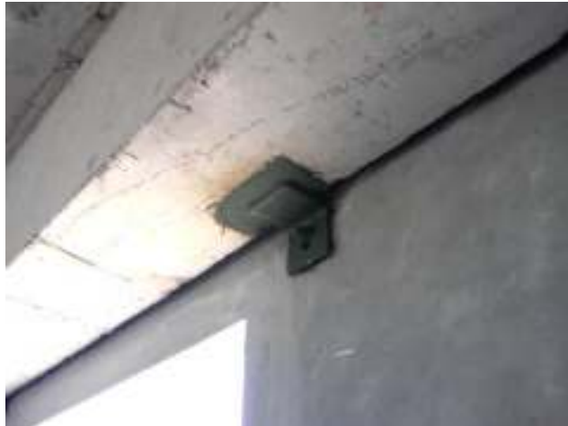
Gambar 4.13 Sistem Sambungan Panel Dinding Dengan Balok
