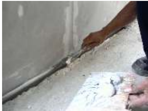
Gambar 4.16 Pemasangan Sealent
