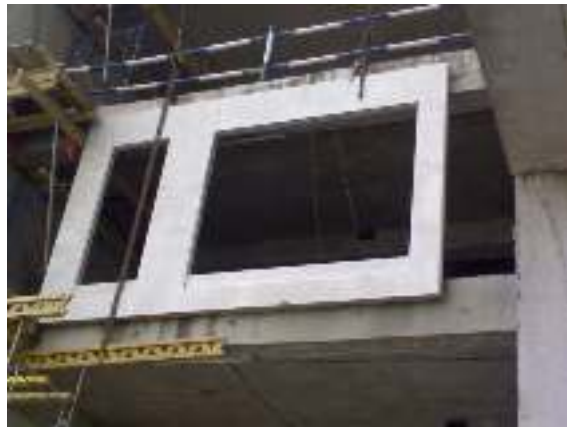
Gambar 4.15 Pemasangan Elemen Dinding Precast
