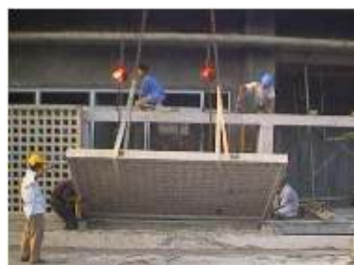
Gambar 4.10 Pemasangan dengan Takel
