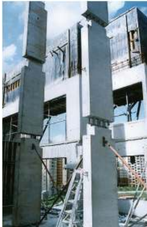
Gambar 4.8 Sistem Struktur Precast KML
