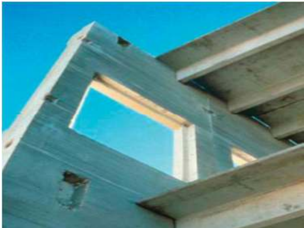
Gambar 4.26 komponen atap precast
