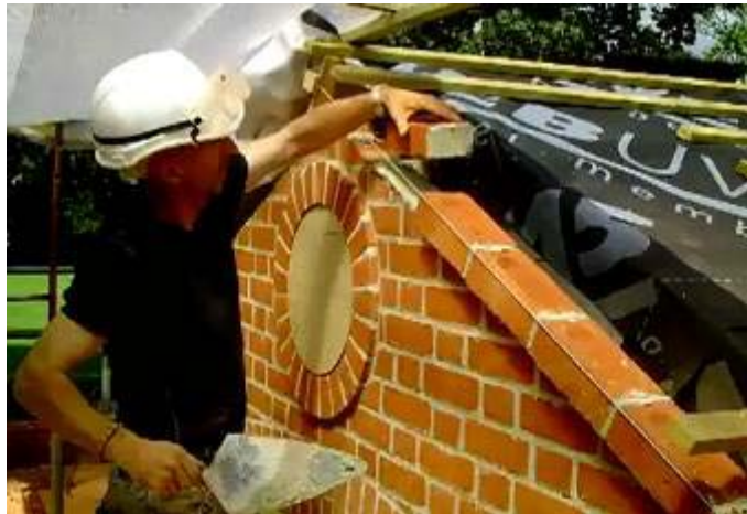
Gbr 4.87 Memasang batu bata di atas dinding
