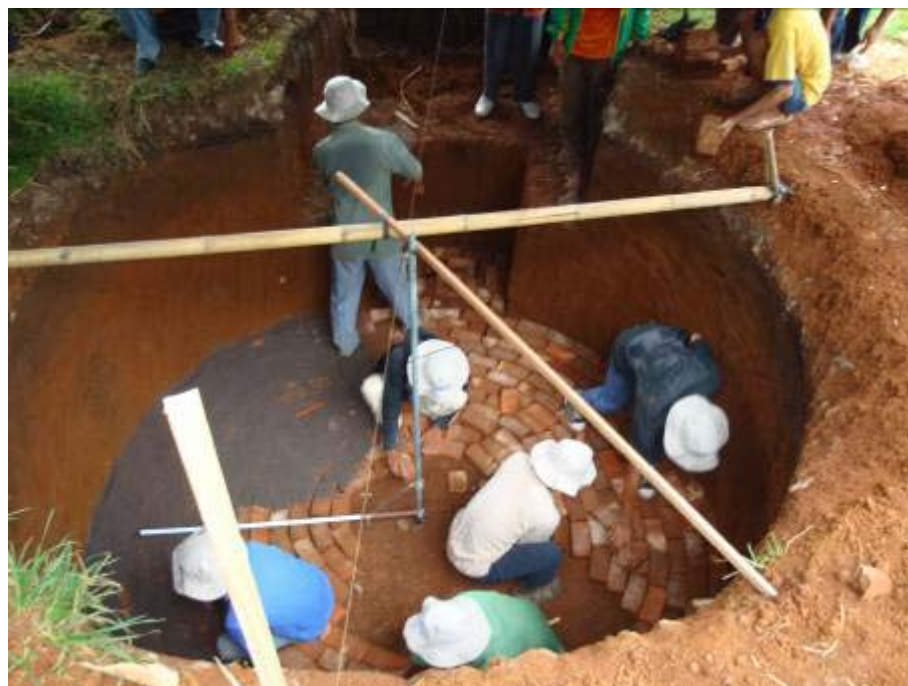
Gbr 4.141 Pemasangan lantai kerja
