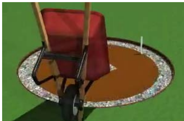
Gbr 4.131 Menuangkan kerikil sebagai lantai kerja
