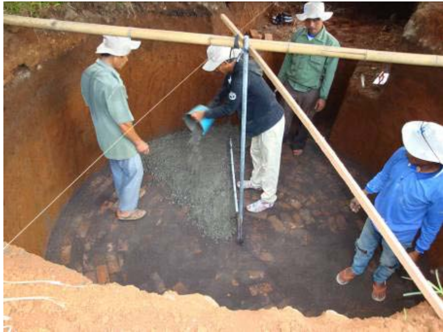
Gbr 4.144 Menghamparkan beton di atas lantai kerja
