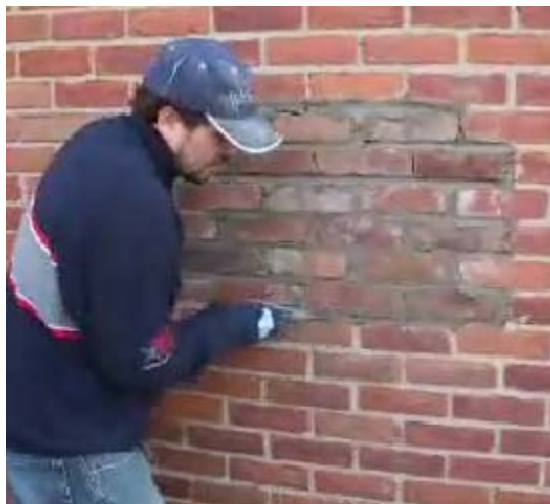
Gbr 4.119 Merapihkan nat yang sudah dipasang
