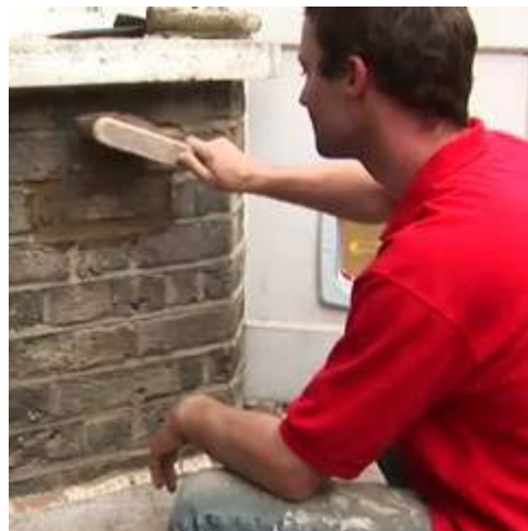
Gbr 4.114 Bersihkan hasil pekerjaan
