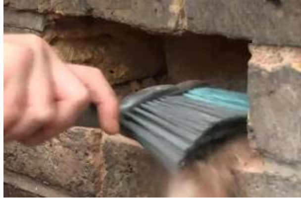
Gbr 4.105 Membersihkan lubang bekas bata rusak dengan sikat/kuas
