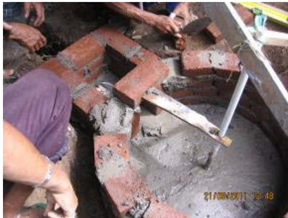
Gbr 4.121 Contoh mal dari bilah papan dengan as dari pipa pvc
