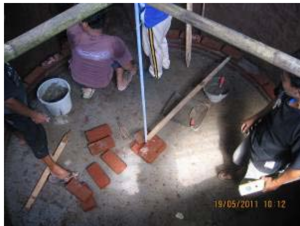
Gbr 4.122 Contoh mal dari besi dengan as dari pipa galvanisir
