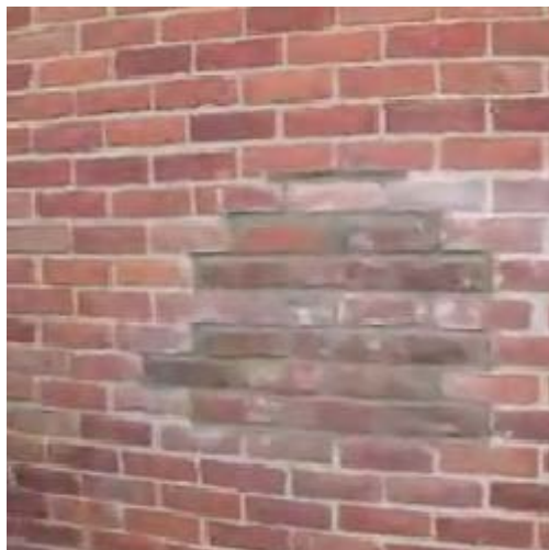
Gbr 4.120 Hasil perbaikan bata yang rusak
