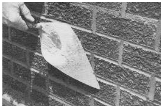
Gbr 4.81 Membersihkan sisa-sisa adukan dengan menggunakan sendok semen/spesi
