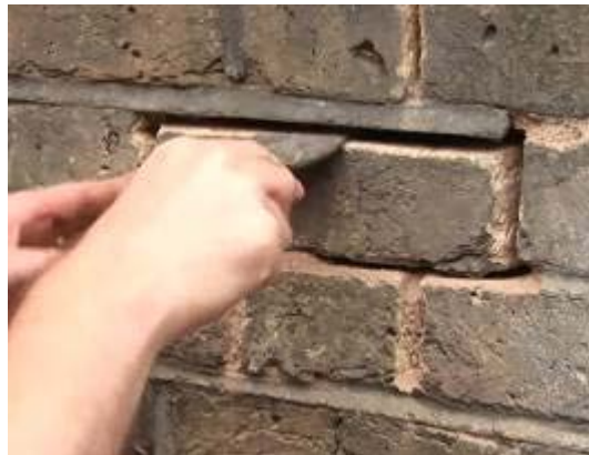
Gbr 4.103 Mengeluarkan bata yang rusak dengan bolster atau alat lain
