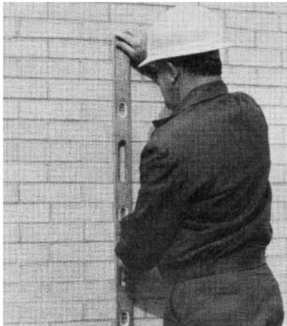
Gbr 4.156 Memeriksa ketegakan dinding dan kelurusanat pasangan bata dengan waterpass atau mistar pelurus
