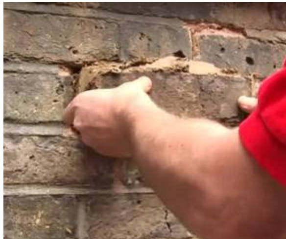
Gbr 4.110 Memasukkan bata yang sudah diberi adukan
