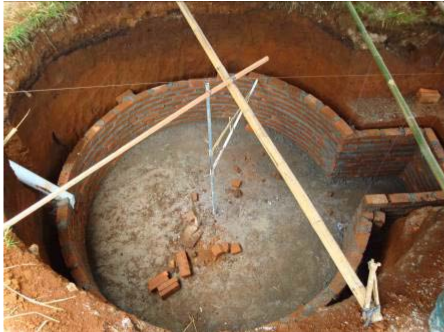
Gbr 4.150 Pekerjaan pemasangan dinding lengkung selesai dilaksanakan
