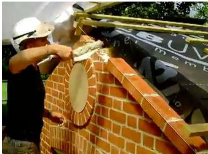
Gbr 4.86 Menghamparkan adukan di atas pasangan dinding bata.
