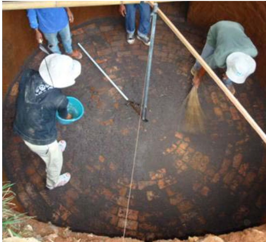
Gbr 4.142 Pengisian pasir di celah-celah pasangan bata tanpa adukan
