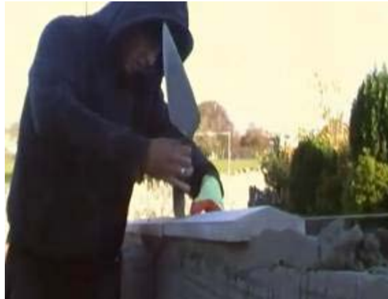
Gbr 4.93 Menyesuaikan posisi kop beton pracetak dengan benang
