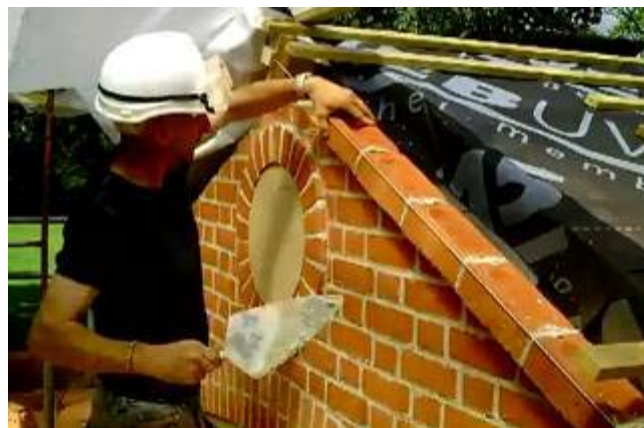
Gbr 4.88 Menyesuaikan posisi batu bata dengan benang
