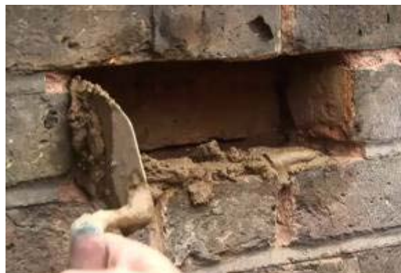
Gbr 4.108 Hamparkan adukan pada lubang
