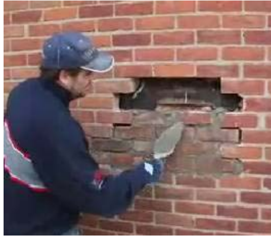
Gbr 4.118 Memasang bata pengganti
