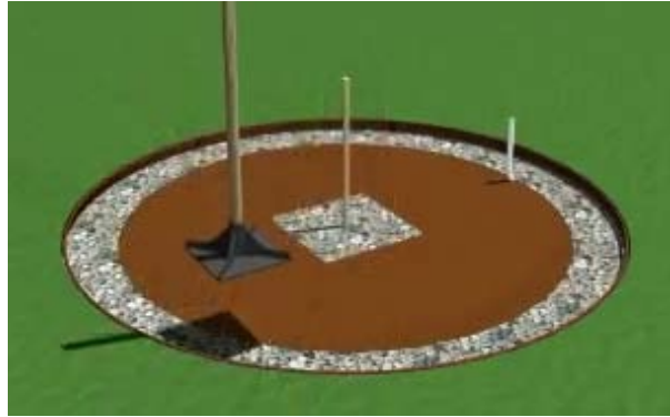
Gbr 4.132 Memadatkan kerikil yang telah dituangkan
