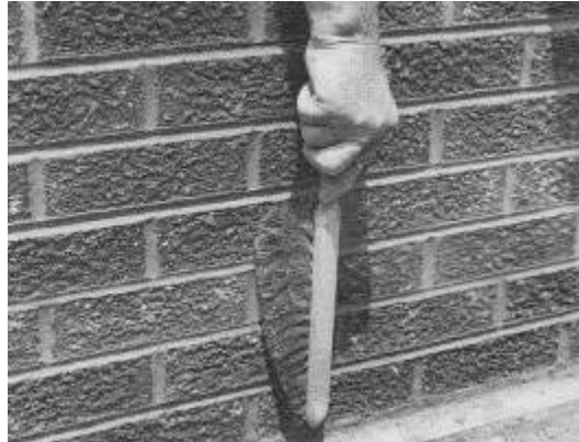
Gbr 4.82 Membersihkan dinding dengan menggunakan sikat kawat
