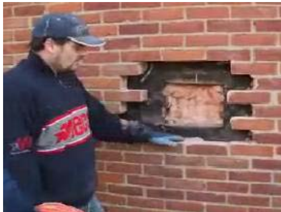
Gbr 4.116 Siram daerah yang akan dipasang bata dengan air.
