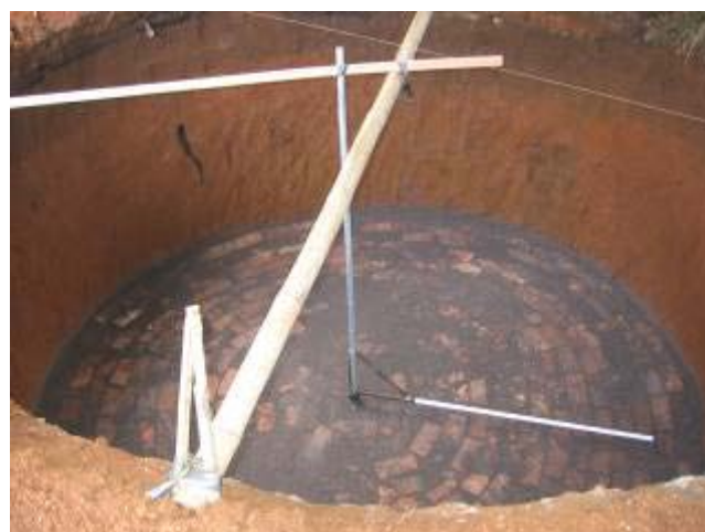
Gbr 4.121 Contoh mal dari bilah papan dengan as dari pipa pvc
