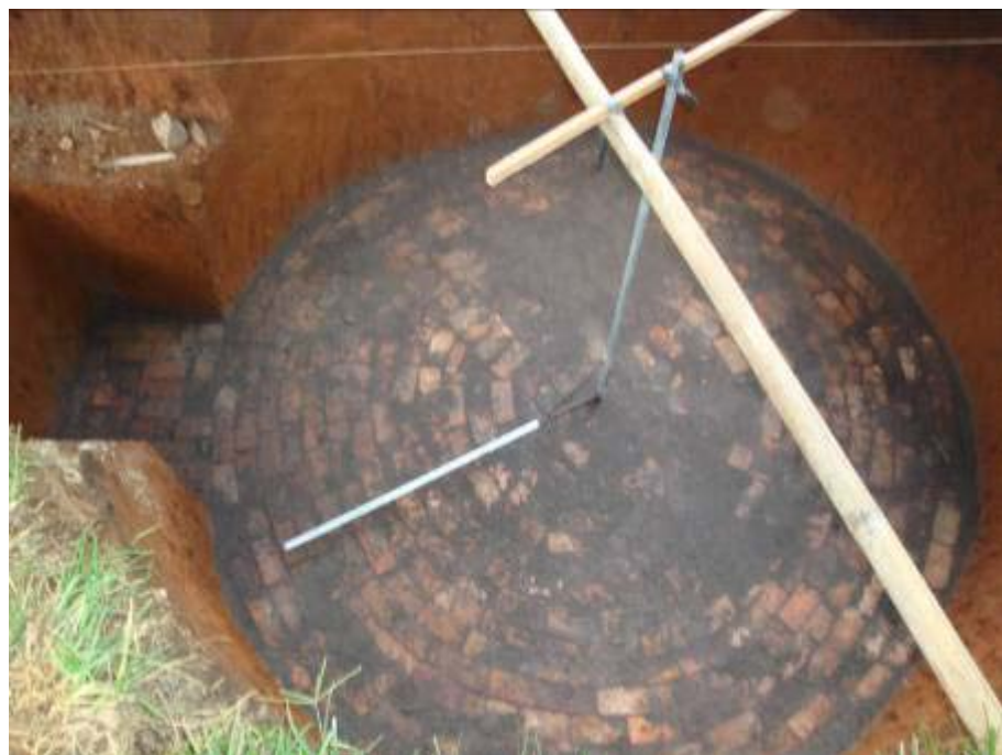
Gbr 4.143 Lantai kerja yang siap untuk digunakan
