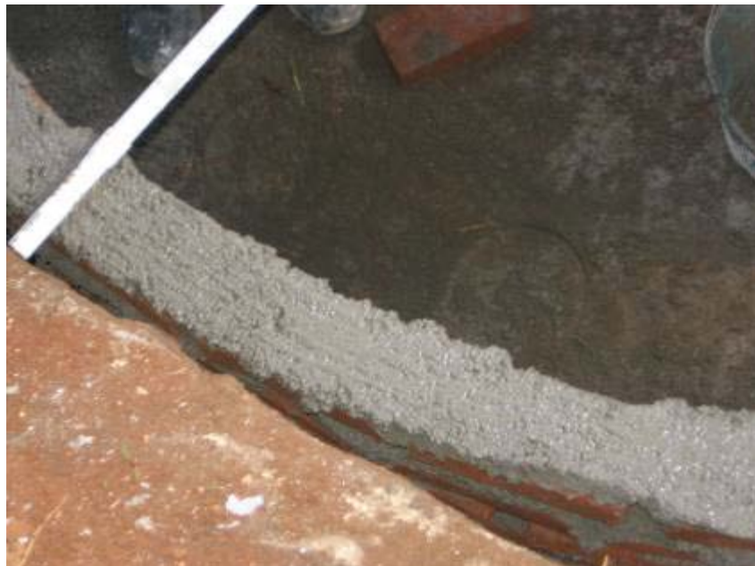
Gbr 4.152 Memlester bagian atas dinding lengkung
