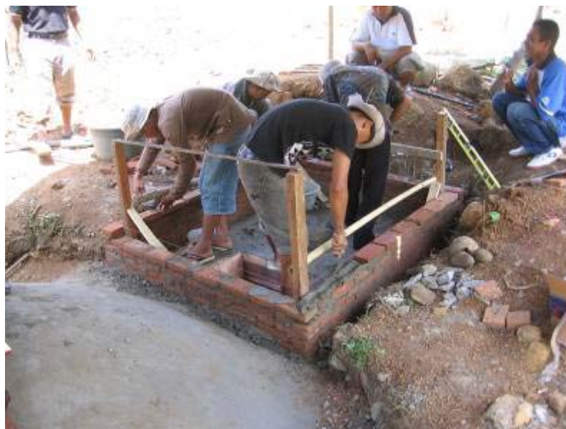
Gbr 4.18 Pemasangan bata dengan menggunakan profil
