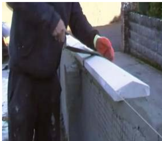
Gbr 4.94 Mengisi celah antara beton pracetak dengan adukan
