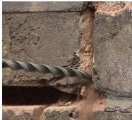
Gbr 4.101 Mengorek nat dengan alat pengorek atau bor tangan
