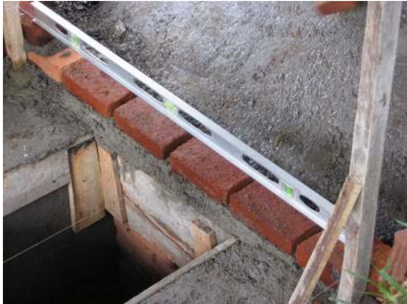
Gbr 4.34 Mengatur kedataran, ketinggian nat dan ketegakan bata antara dengan waterpass
