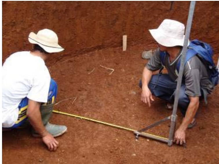
Gbr 4.140 Memeriksa ketepatan kedudukan tiang as
