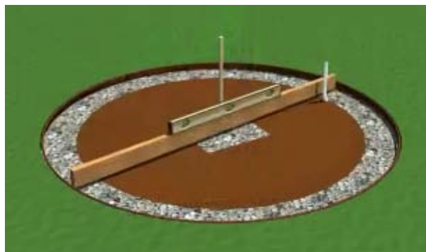
Gbr 4.134 Memeriksa kedataran lantai kerja
