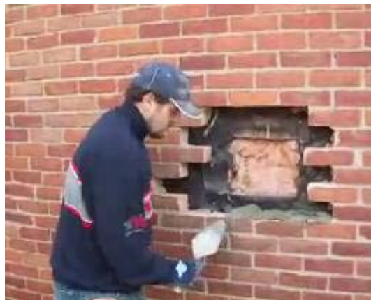
Gbr 4.117 Menghamparkan adukan pada daerah yang telah dibersihkan
