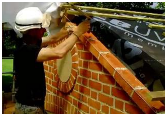
Gbr 4.89 Mengatur posisi batu bata
