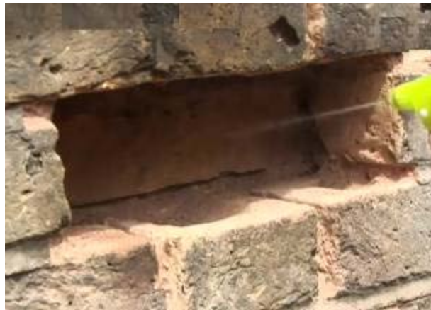
Gbr 4.107. Siram lubang dengan air
