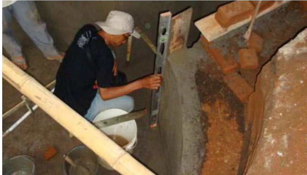
Gbr 4.155 Pemeriksaan ketegakan dinding lengkung
