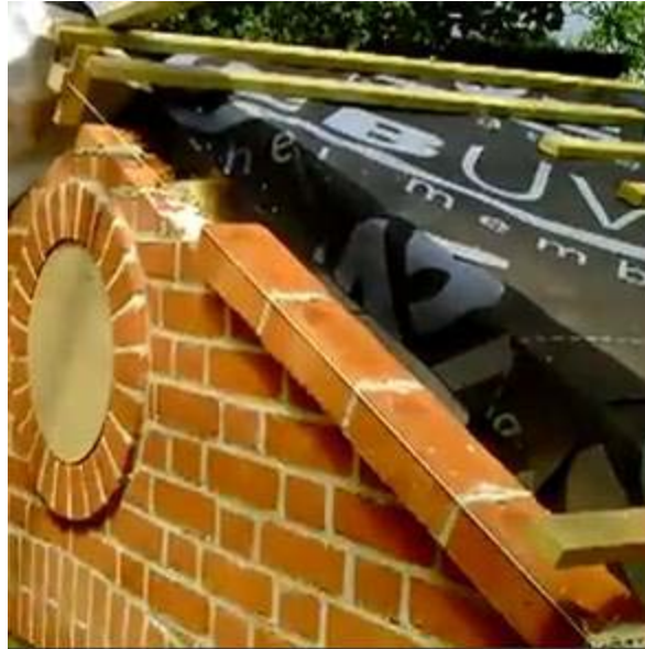
Gbr 4.85 Pemasangan benang sebagai profil
