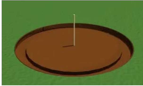
Gbr 4.129 Penggalian lubang kepala untuk rantai kerja
