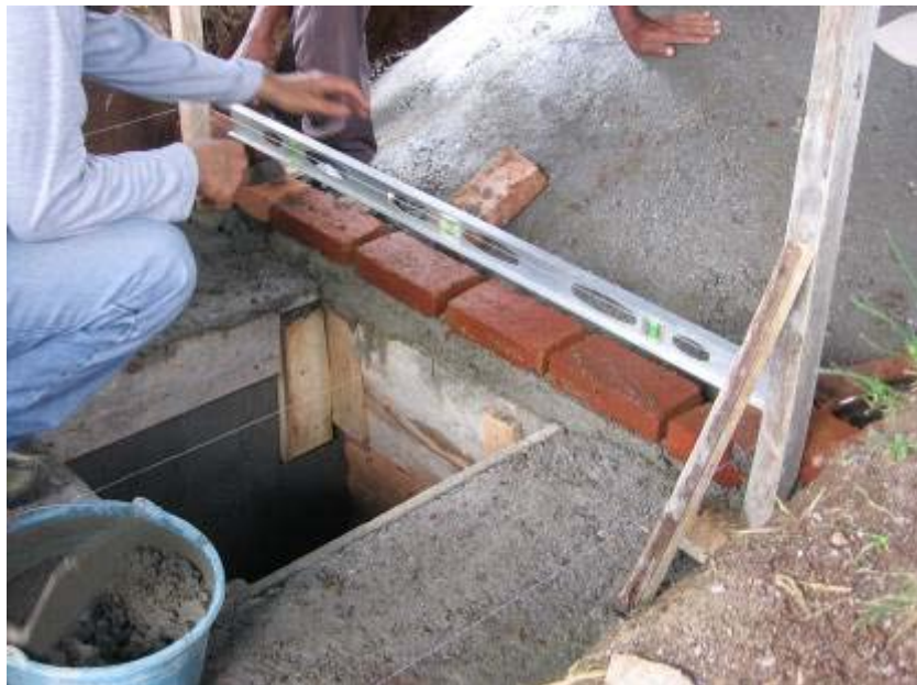
Gbr 4.35 Memasang bata-bata ujung lapisan kedua dan memeriksa kedataran dan tinggi nat
