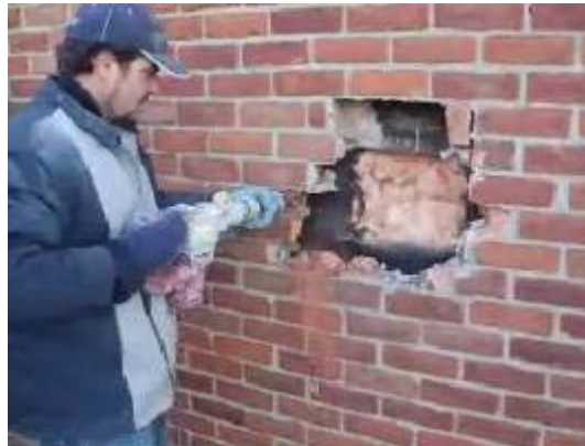
Gbr 4.115 Merapihkan sisa pembongkaran bata yang rusak
