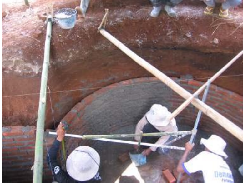
Gbr 4.151 Menghamparkan adukan pada dinding lengkung sebagai persiapan pemlesteran.
