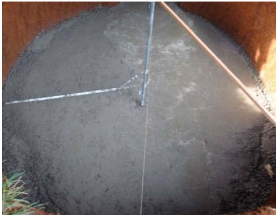
Gbr 4.145 Lantai pondasi yang telah selesai dicor.
