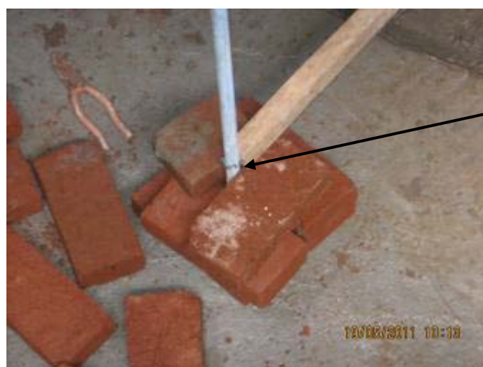
Gbr 4.123 Contoh mal dari kayu 2/3 dengan as dari pipa galvanisir
