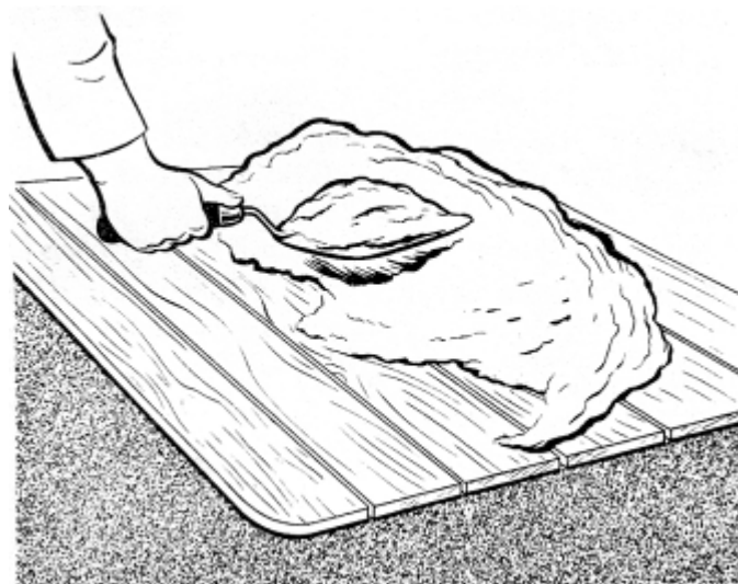
Gbr 4.29 Pengambilan adukan dari tempatnya dengan menggunakan sendok spesi
