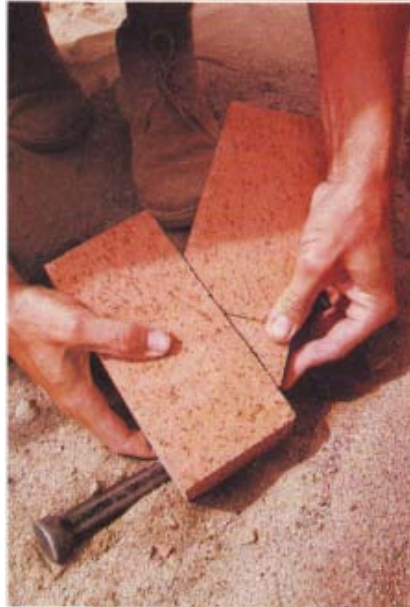
Gbr. 4.7 Menggaris bata yang akan dipotong
