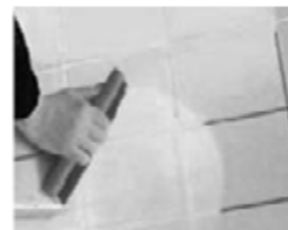
Gbr. 4.37 Mengisi nat pemasangan
