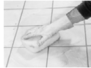
Gbr. 4.38 Membersihkan nat pasangan
