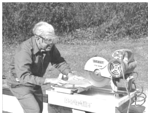
Gbr. 4.19 Memotong ubin dengan mesin statis
