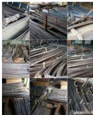
Gambar 2.5 Penyimpanan besi beton
