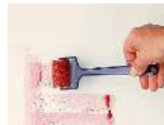
Gb. 22 Roller spons (a), roller wool (b) dan cara menggunakannya (c)
