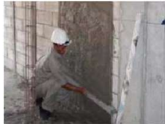
Gambar Pekerjaan plesteran
