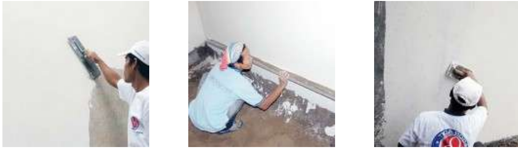
Gambar 8.21. pengacian permukaan plesteran.
